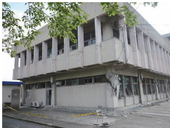
写真 B-42 建築物外観（東側）
