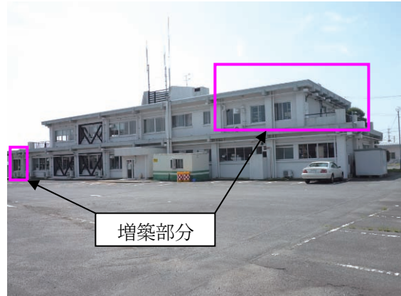
写真 B-48 建築物外観（北側）
