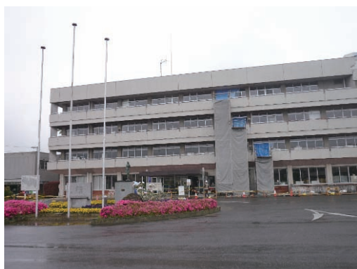
写真B-13 建築物外観
