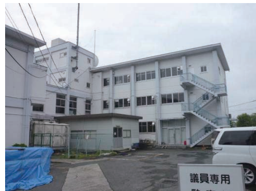
写真 B-32 建築物外観（北面）
