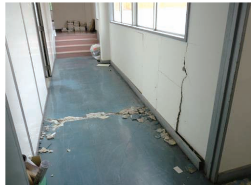
写真 B-5 建築物 B' との接続部（2 階）
