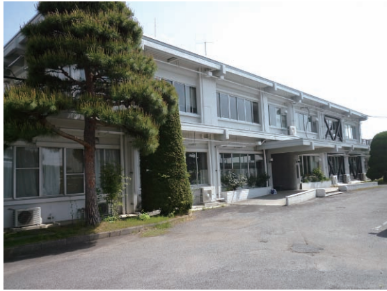
写真 B-47 建築物外観（南側）
