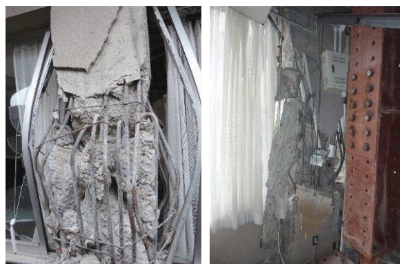
写真B-14 腰壁付き柱のせん断破壊(1階)
