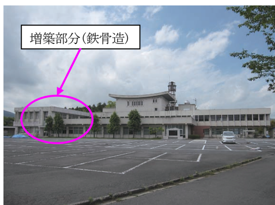
写真 B-41 建築物外観（南側）
