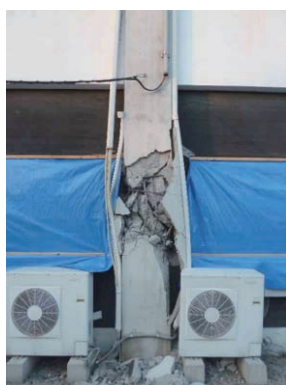
(b) 短柱せん断破壊
