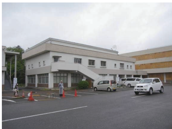
写真 B-10 建築物外観
