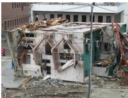
写真 1.4.1 3階建て鉄骨造の転倒
