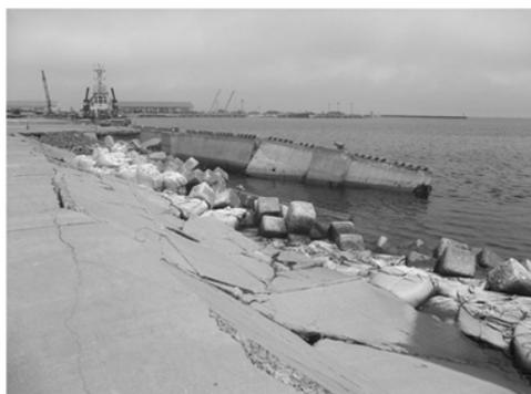
写真-3 岸壁の倒壊（相馬港）
