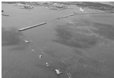
写真-1 防波堤の倒壊（八戸港）<sup>2)</sup>
