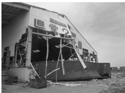
写真-5 上屋の損傷（相馬港）
