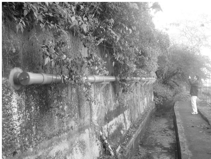
写真－１ クイック配管（露出配管）
