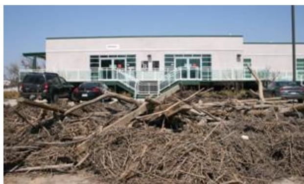
図-26 嵩上げと防災機能強化によりハリケーン・アイクによる浸水被害を免れた病院（Cameron 郡）
