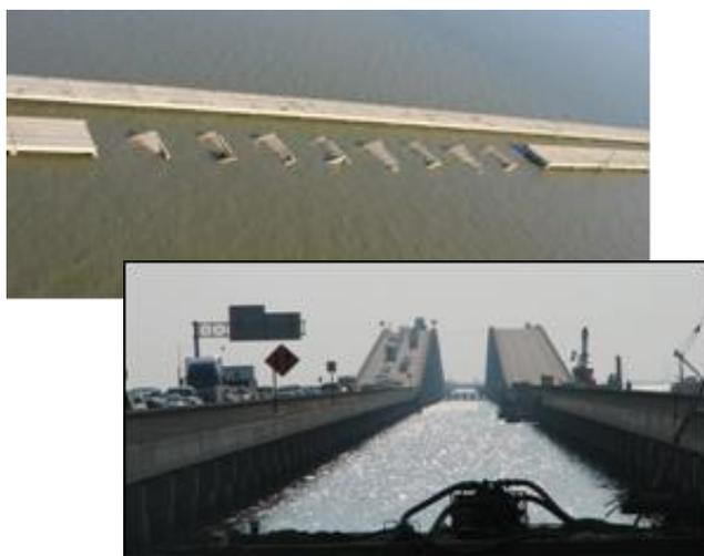
図-14 ハリケーンで損傷した州間高速（I-10）ツイン・スパン（上：被害の状況，下：1本目の暫定開通時の状況）
