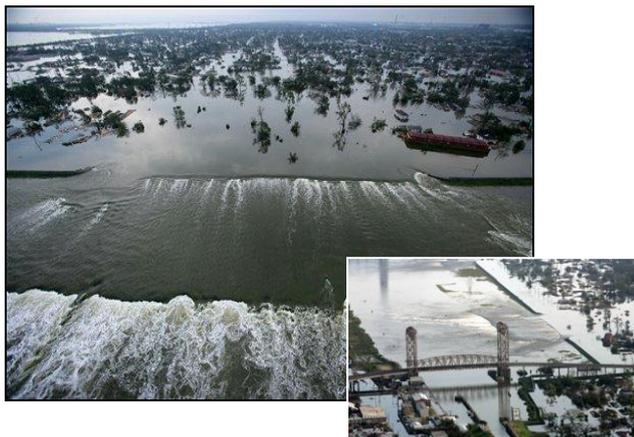
図-4 運河沿いの破堤した堤防から市街地 (lower 9th ward) への浸水状況
