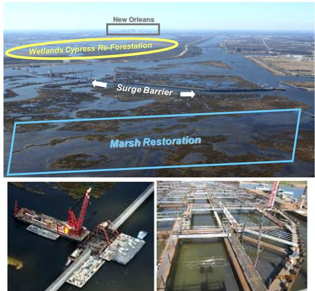
図-23 工業運河—ボーン湖防潮堤（IHNC-Lake Borgne Surge Barrier, 下）と3重の浸水防護構造（上）
