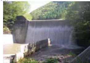
5/27 15時頃の従前の状態に戻った金原砂防堰堤
