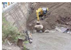
5/26～27 堰堤上流部での巨石投入作業状況
