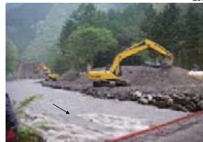
5/25～ 堰堤下流部の河床に堆積した土砂撤去作業状況
