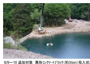
6/9～10 追加対策 異形コンクリートブロック(約3ton)投入状況
