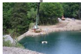
6/9～10 追加対策 異形コンクリートブロック（約3ton）投入状況
