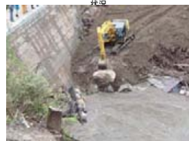
5/26～27 堰堤上流部での巨石投入作業状況
