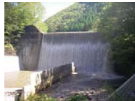
5/27 15時頃の従前の状態に戻った金原砂防堰堤
