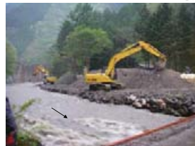
5/25～ 堰堤下流部の河床に堆積した土砂撤去作業状況
