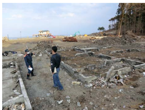
写真 7.3.8-1 火災現場付近
