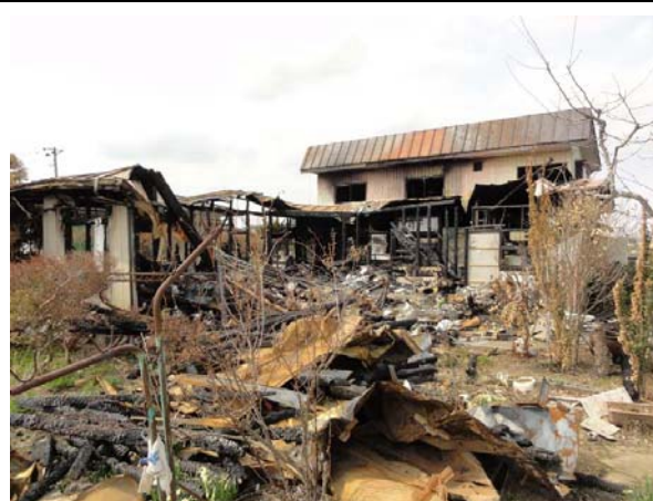
写真 7.3.22 奥州市水沢区小石田の火災
