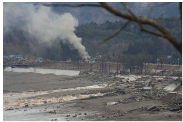
写真 7.3.8-2 火災現場付近
