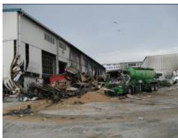
写真 7.3.1-1 仙台塩釜港北側の駐車場 1 の火災
