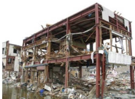
写真 6.5.2-2 残存 S 造骨組み
