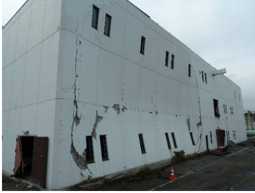
写真 6. 3. 10-44 第3 ポンプ室 外観
