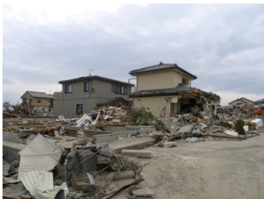
写真 6. 3. 13-27 残存する木造と鉄骨造住宅 (19)
