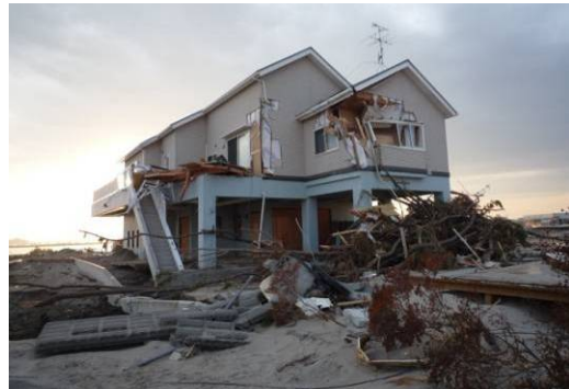
写真 6.3.13-6 残存する立面混構造建物 (②)
