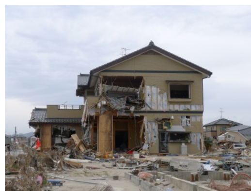
写真 6. 3. 13-28 残存する木造住宅 (20)
