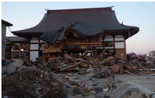
写真 6. 3. 11-3 大きく損壊した寺社建築 (②)
