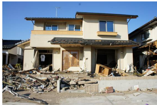
写真 6. 3. 10-38 築一年未満の木造建物
