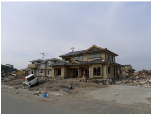
写真 6. 3. 11-56 残存した木造と鉄骨造住宅 (④)
