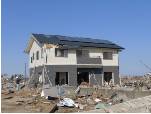
写真 6. 3. 10-19 残存した木造住宅 (⑧)
