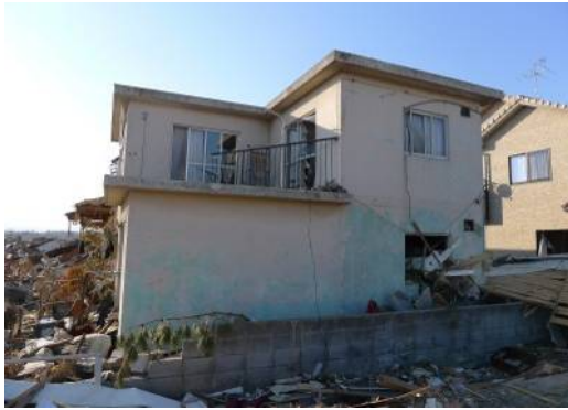
写真 6. 3. 10-27 残存する RC 造住宅 (⑬)
