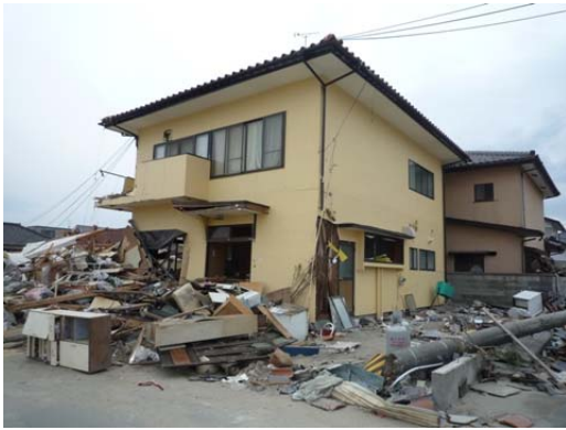
写真 6. 3. 13-13 残存した比較的古い木造 (⑦)
