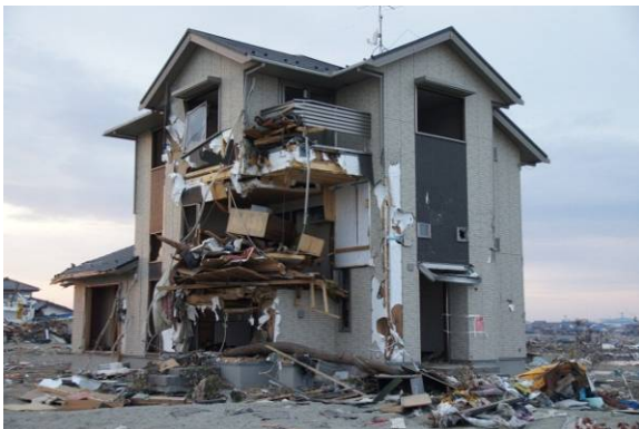
写真 6. 3. 13-11 残存する 3 階建木造住宅 (④)
