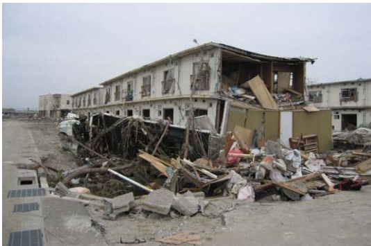
写真 6. 3. 11-25 建物東端 1 戸分の崩壊 (16)
