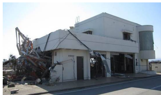
写真 6. 3. 10-8 住宅の外観 (②)
