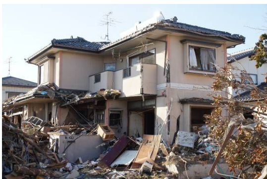
写真 6. 3. 10-40 残存する木造建物 (19)
