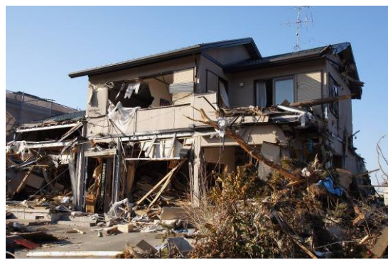
写真 6. 3. 10-36 残存する軽量鉄骨造建物 (17)
