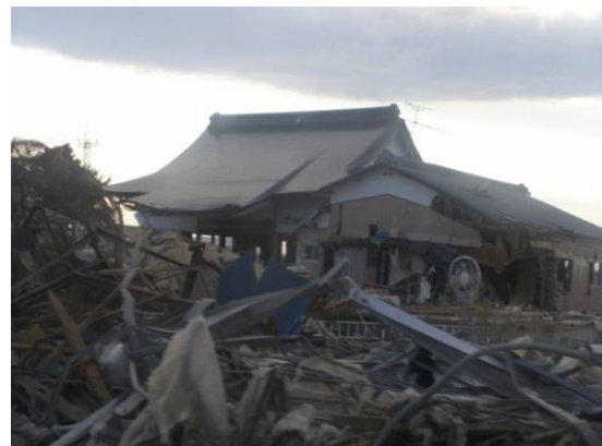
写真 6. 3. 12-8 寺院の被害例（寺島地区）
