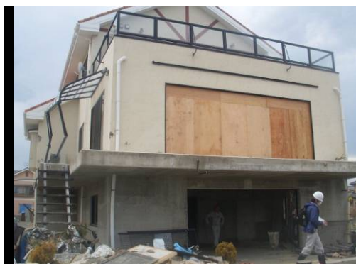
写真 6. 3. 13-32 海側の開口部
