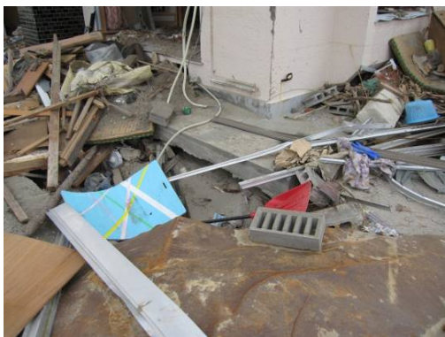
写真 6. 3. 14-9 周辺地盤の洗掘
