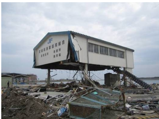
写真 6. 3. 13-35 建物外観 (㉔)
