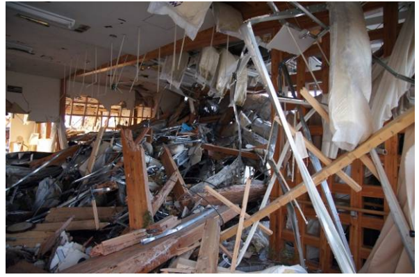
写真 6. 3. 13-10 写真 6. 3. 13-7 の建物内部
