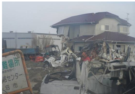
写真 6. 3. 12-4 隅角部や壁面側躯体を失った住宅（押分）
