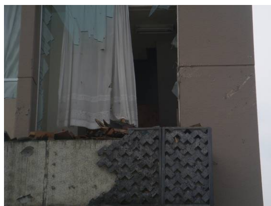
写真 6. 3. 11-38 2F の浸水痕
