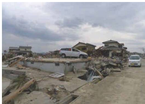
写真6. 3. 13-30 流失した木造住宅群 (㉒)
