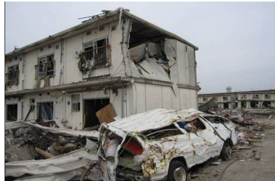
写真 6. 3. 11-26 2 階妻壁の損傷
