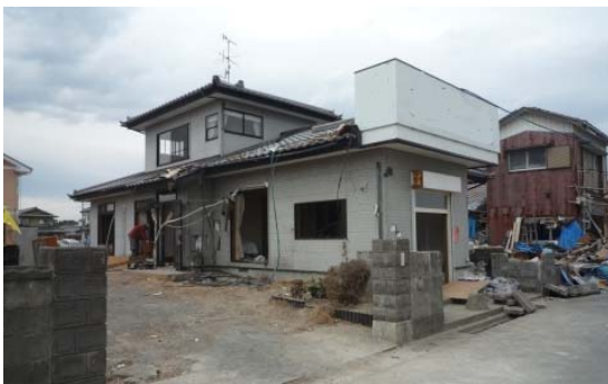
写真 6. 3. 13-17 津波作用方向から見た混構造の反対側で残った店舗併用住宅 (⑨)
