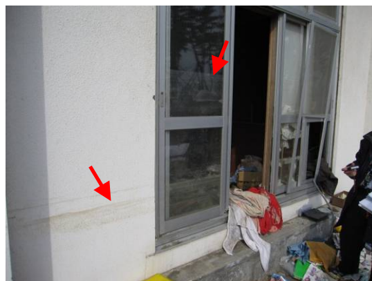
写真 6. 3. 11-64 1 階の浸水痕
