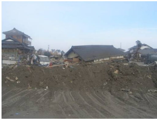
写真 6. 3. 12-1 住宅の移動及び転倒（押分）
