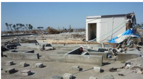
写真 6. 3. 10-7 土台も流失した例
