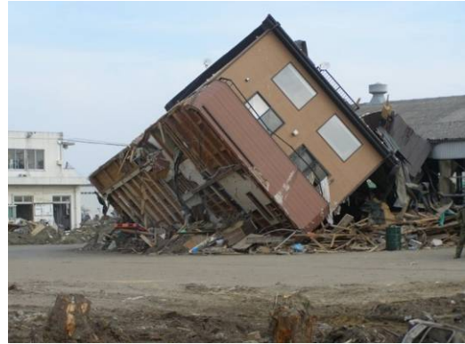
写真 6. 3. 12-2 転倒した住宅（押分）
