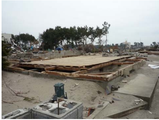
写真 6. 3. 11-7 なぎ倒された保安林と流失家屋の基礎、土台および1階床 (⑥)
