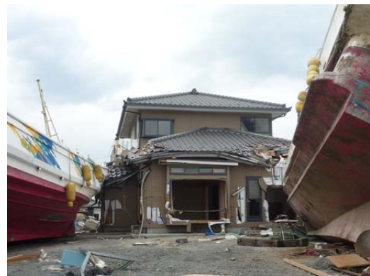
写真 6. 3. 13-14 2 隻の船舶が衝突した木造 (⑥)
