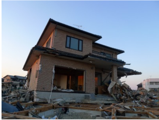
写真 6. 3. 11-1 基礎ごと流された木造 (①)
