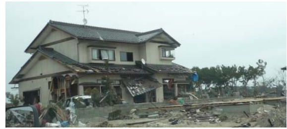
写真 6. 3. 11-8 残存する保安林と木造家屋 (⑦)
