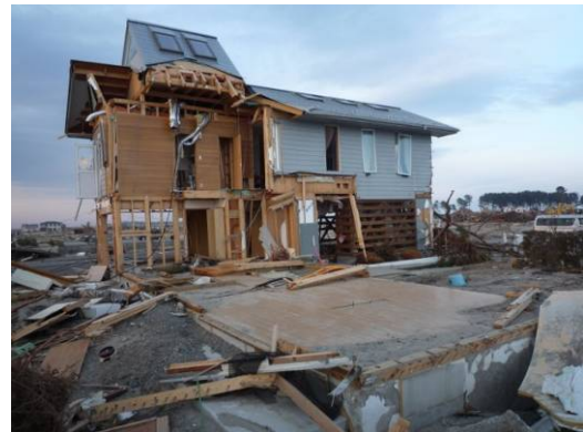
写真6.3.13-4 残存する木造住宅木造住宅
