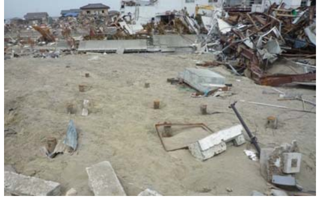
写真 6. 3. 11-2 写真 6. 3. 11-2 の当初位置に残る杭
