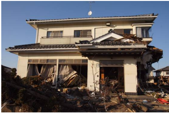
写真 6. 3. 10-42 残存する木造建物
