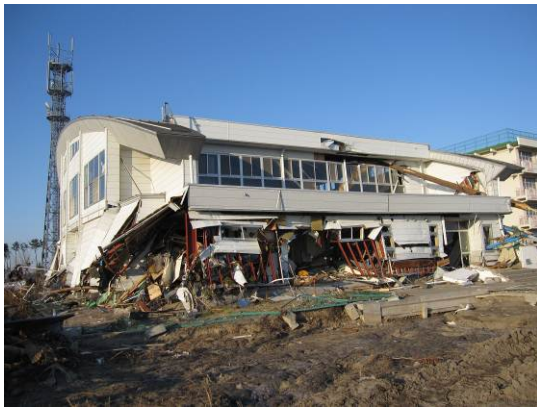
写真 6. 3. 10-17 荒浜小学校体育館外観 (㉗)
