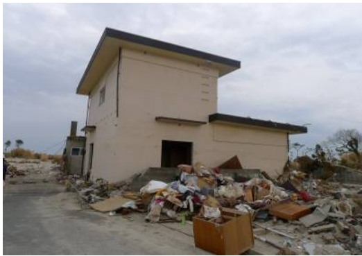
写真 6. 3. 14-1 残存する RC 造建物 (①)
