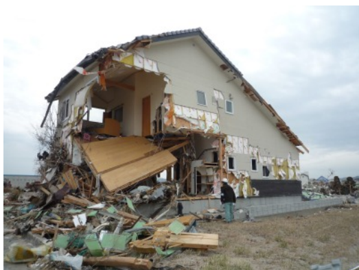
写真 6. 3. 13-23 残存する木造住宅 (15)
