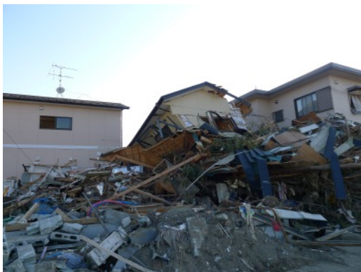
写真 6. 3. 10-31 損傷の激しい木造
