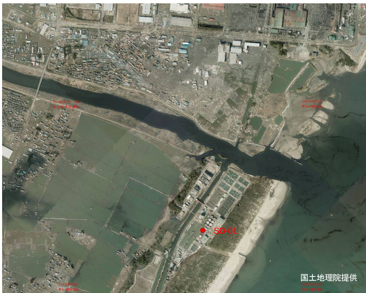
図 6.3.10-2 仙台市宮城野区南蒲生の調査建物
