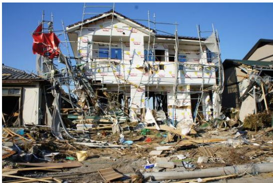
写真 6. 3. 10-37 建設途中の木造建物
