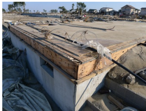
写真 6. 3. 10-22 流失した 2×4 工法住宅
