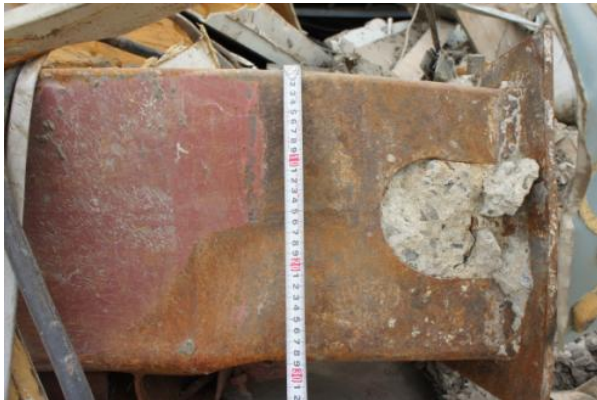
写真 6. 3. 11-24 写真 6. 3. 11-23 の露出柱脚
