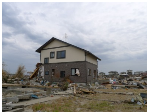
写真 6. 3. 13-24 残存する木造住宅 (16)
