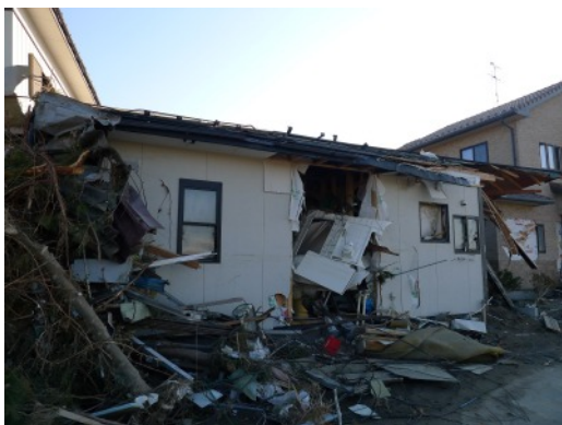
写真 6. 3. 10-33 損傷の激しい木造
