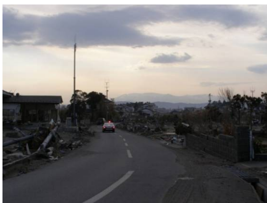
写真 6. 3. 12-5 電柱や塀の倒壊と沿線周辺（押分、寺島地区）
