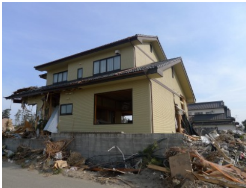
写真 6. 3. 11-61 残存した木造住宅 (⑦)
