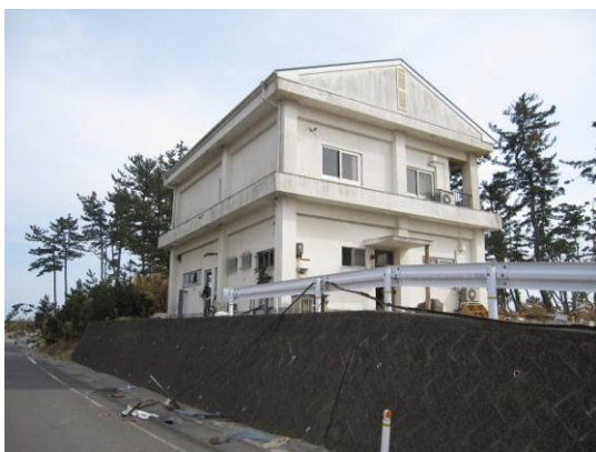
写真 6. 3. 11-63 建物外観 (⑨)
