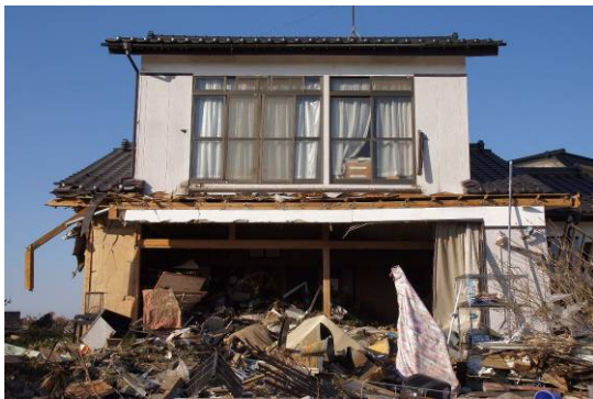
写真 6. 3. 10-39 築 25 年程度の木造建物 (18)
