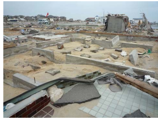
写真 6. 3. 13-16 混構造の北隣りの家屋流失 (⑧)
