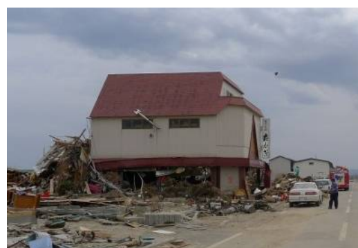
写真 6. 3. 13-26 残存する鉄骨造店舗 (18)
