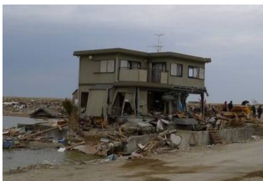
写真 6. 3. 13-25 残存する軽量鉄骨造住宅 (17)
