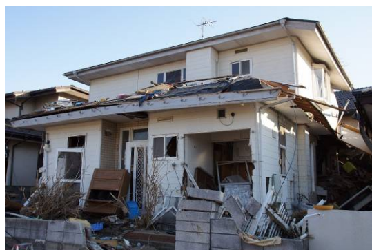
写真 6. 3. 10-41 残存する木造建物
