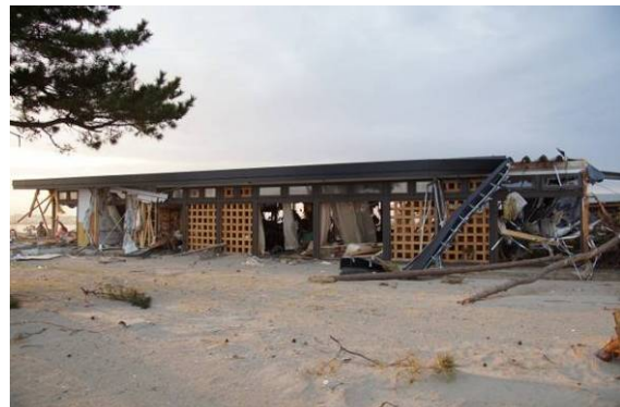
写真 6.3.13-8 写真 6.3.13-7 の桁行方向 (面格子壁)
