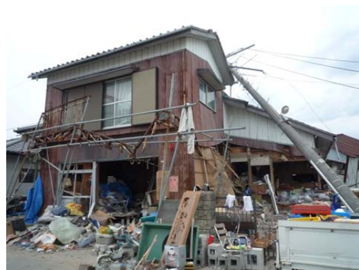
写真 6. 3. 13-18 津波作用方向から見た混構造の反対側で残った構造仕様が劣る住宅 (⑩)
