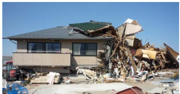
写真 6. 3. 10-4 1 階が層崩壊しても残存している スチールハウス (①)
