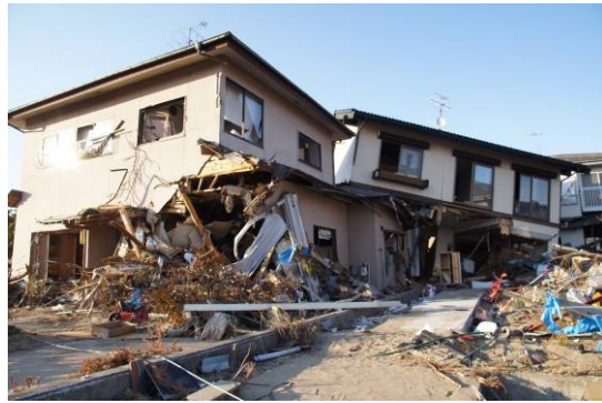
写真 6. 3. 10-43 残存する木造建物(㊟)
