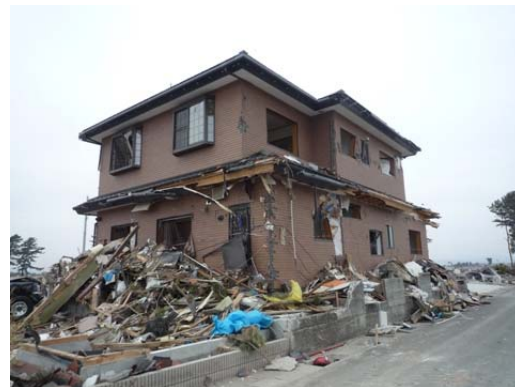
写真 6. 3. 11-11 単独で残存する木造軸組構法住宅 (⑨)
