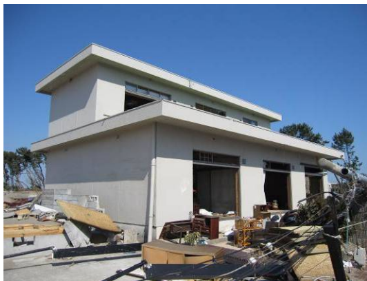
写真 6. 3. 10-9 残存する RC 造住宅 (③)
