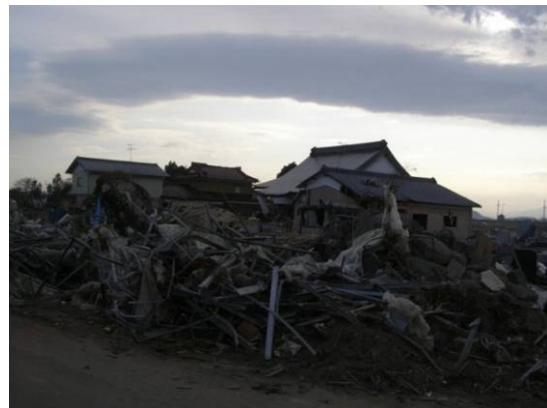
写真 6. 3. 12-6 1 階部分を失った住宅等（押分、寺島地区）
