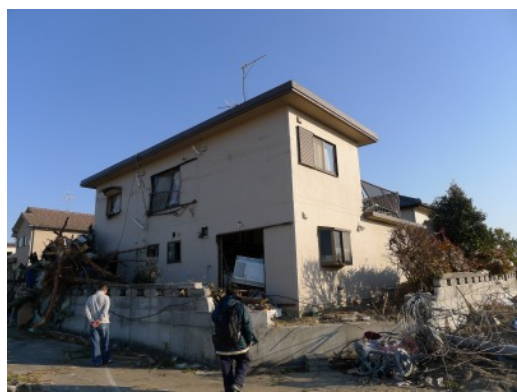
写真 6. 3. 10-30 残存する RC 造 (パネル) 住宅 (⑮)
