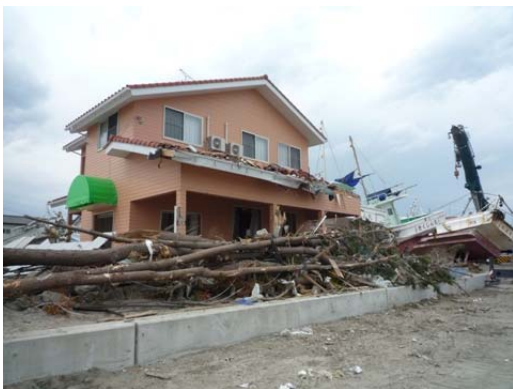
写真 6. 3. 13-13 比較的新しい残存木造 (⑤)
