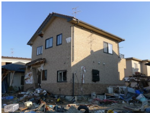
写真 6. 3. 10-32 残存する木造住宅
