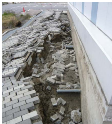
写真 5.5.2.1-21 建築物周囲地盤の状況
