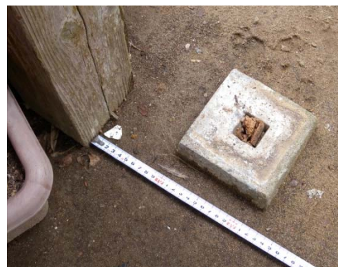
写真5.5.2.1-10 物置柱脚の移動
