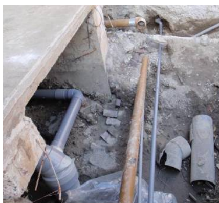
写真 5.5.2.2-17 設備配管の修復状況
