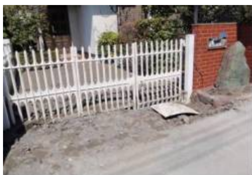
写真 5.5.2.2-3 沈下と敷地内噴砂の状況
