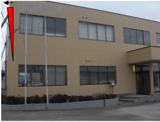
写真 5. 5. 2. 1-15 †) 沈下・傾斜した事務所ビル (同) (長辺方向 5.6/100、短辺方向 1.2/100)
