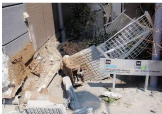
建物間の状況
