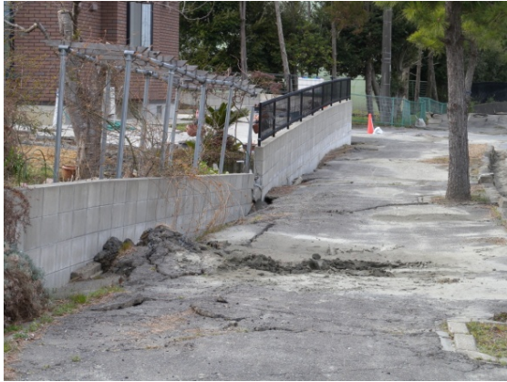
写真 5.5.2.1-27 歩道部分の沈下に伴う塀の被害
