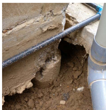
写真5.5.2.1-12 建物角部の支持構造物
