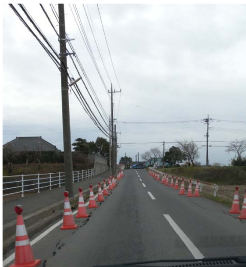
写真 5.5.2.1-2 路盤の亀裂
