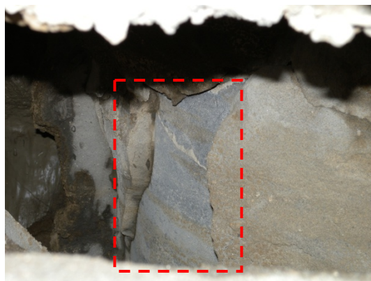
写真 5.5.2.1-23 † 杭周固定液の内部
