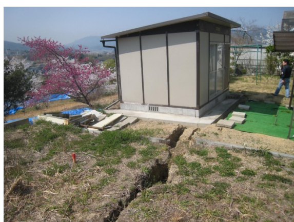
写真 5.5.2.3-29 緑ヶ丘 1 丁目の斜面地①および頂部に生じた地割れ（一部ブルーシート掛け）
