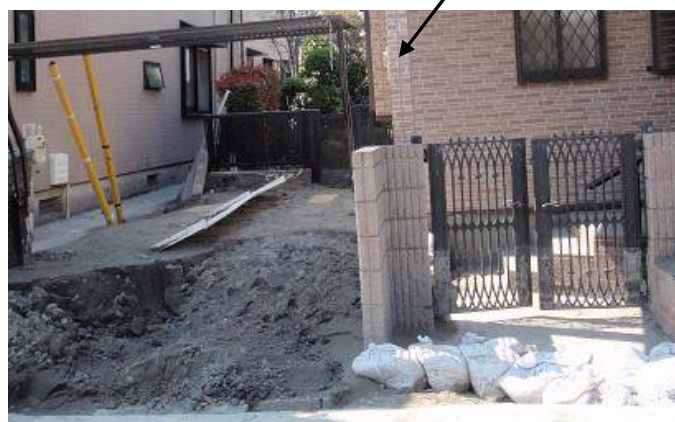
写真 5. 5. 2. 2-6 沈下・傾斜した住宅と噴砂状況 (写真 5. 5. 2. 2-5 の道路を挟んで向かい側の住宅)
