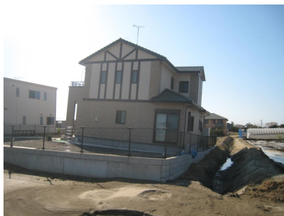
写真 5. 5. 2. 1-44 写真 5. 5. 2. 1-43 の戸建て住宅を反対側より臨む
