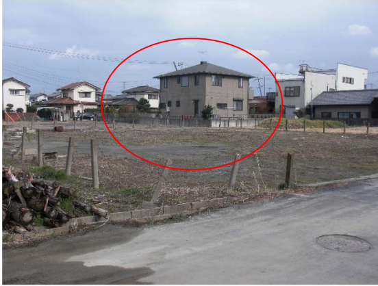
写真 5.5.2.1-33 †) 液状化の発生していない住宅
