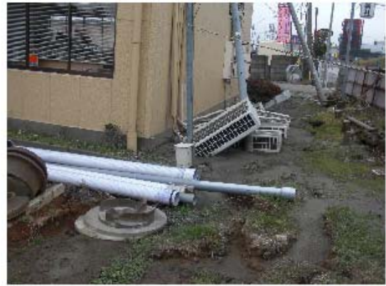
写真 5. 5. 2. 1-16 †) 写真 5. 5. 2. 1-15 の周囲の変状 (右側が県道 11 号)
