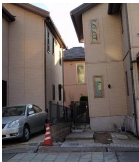
写真 5.5.2.2-18 傾斜した住宅
