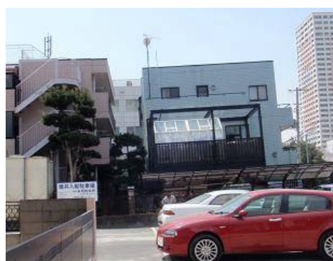
写真 5. 5. 2. 2-15 沈下・傾斜した建物
