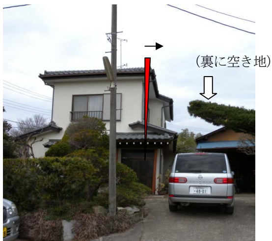
写真5.5.2.1-7 傾斜4/100程度の建築物
