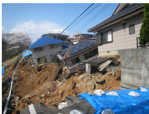
写真 5.5.2.3-46 丘陵の南西側の斜面地①の地すべりと滑り落ちかけた住宅
