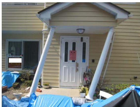
写真 5.5.2.3-2 宅地盛土の滑動・地盤変状の差異により生じた門柱の傾斜
