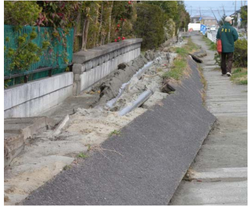
写真 5.5.2.1-27 歩道部分の沈下に伴う塀の被害
