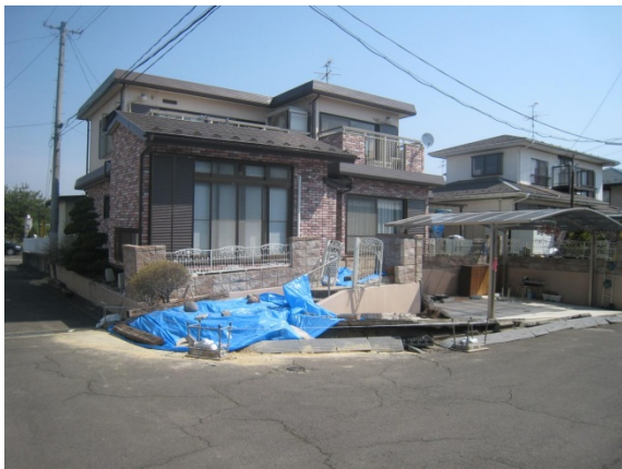
写真 5.5.2.3-33 丘陵地の頂部付近③で宅地盛土の変状により被災した住宅
