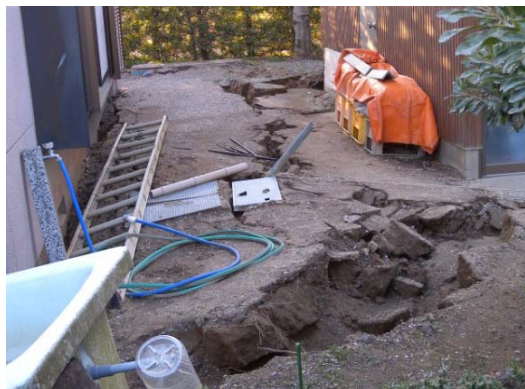
写真 5.5.2.1-37 敷地内の地割れ
