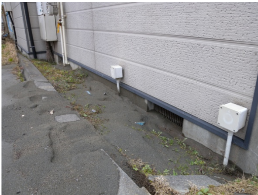
写真 5.5.2.1-31 基礎部分の外観（1）
