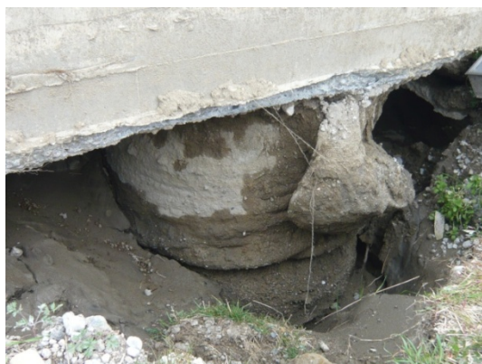
写真 5.5.2.1-22 † 杭頭部の露出状況
