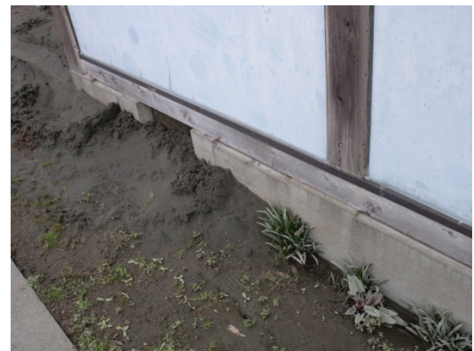
写真 5.5.2.1-32 基礎部分の外観（2）
