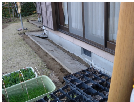
写真 5.5.2.1-38 基礎部分外観
