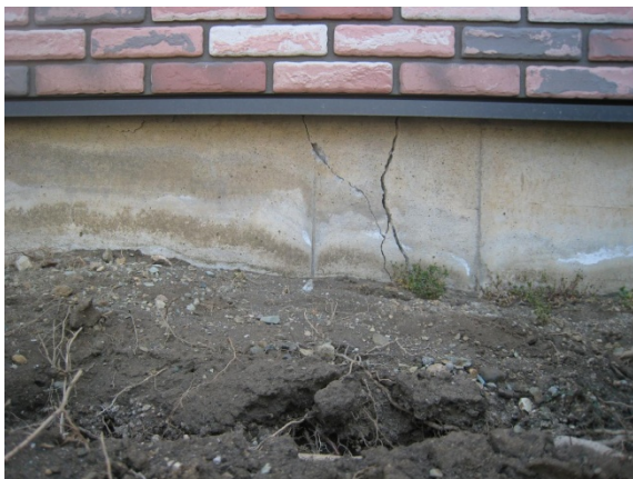
写真 5.5.2.3-35 写真 5.5.2.3-33 の住宅の基礎の損傷と盛土の変状
