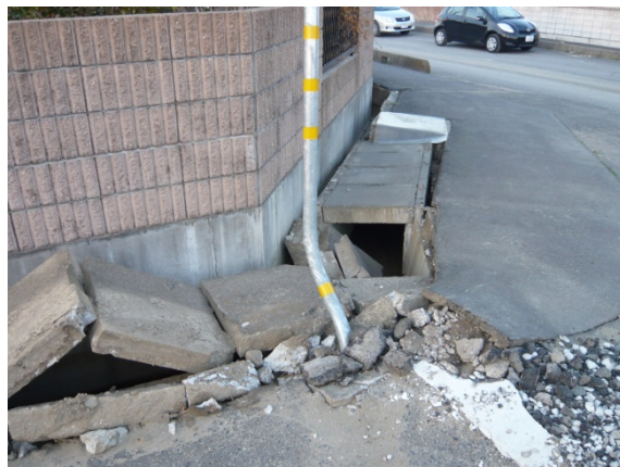
写真 5. 5. 2. 1-40 側溝の被害
