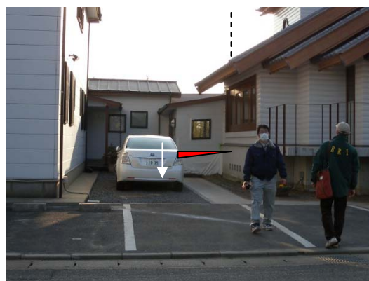
写真 5.5.2.1-36 接続部分の損傷及び駐車場
