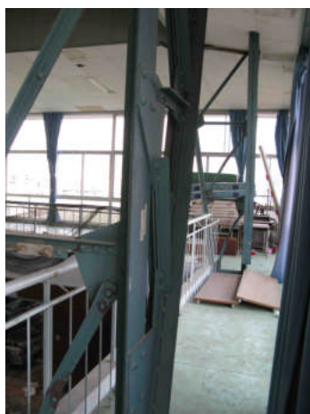
(a) ラチス柱全景
