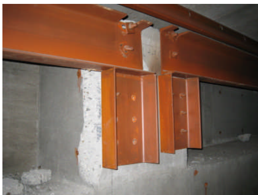
写真 5.3-23 ホールインアンカーの抜け出し跡 (MIT-1)
