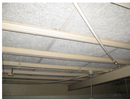
写真 5.3-26 ターンバックルのたわみ (MIT-27)
