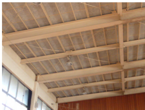
写真 5.3-27 ターンバックルのたわみ (MIT-25)
