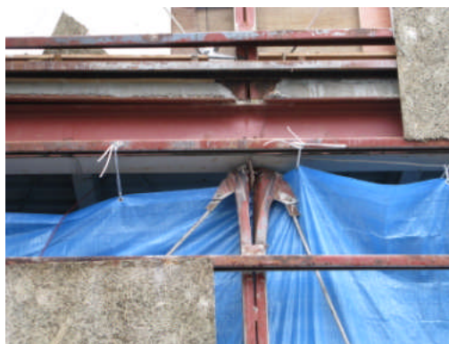
写真 5.3-2 S 造のブレース付き間柱接合部の変形 (仙台市若林区)
