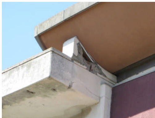
写真 5.3-24 外部の屋根支承部 (MIT-26)
