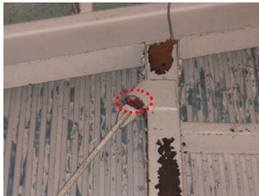
写真 5. 3-17 ボルトの破断 (JS0-3)
