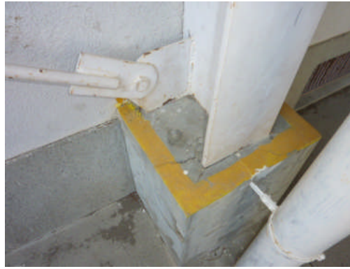
写真 5.3-34 亀裂 (MIT-22)
