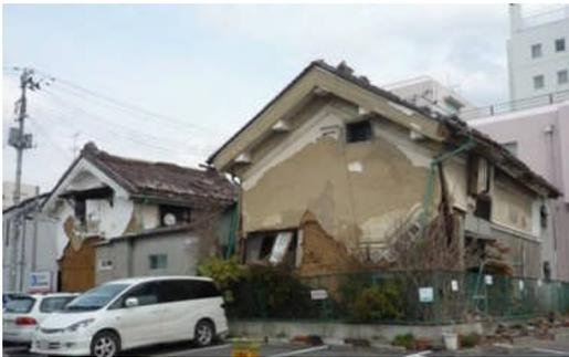
写真 5.2.6-11 大きく損壊して残留変形
