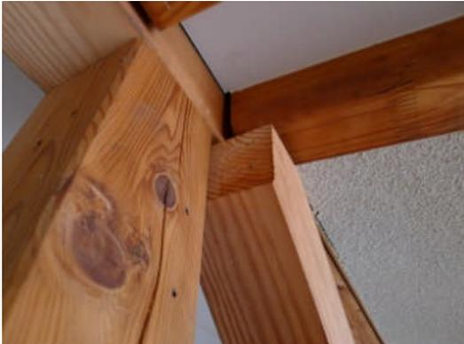
写真5.2.10-11 写真5.2.10-10の筋かいのはずれ
