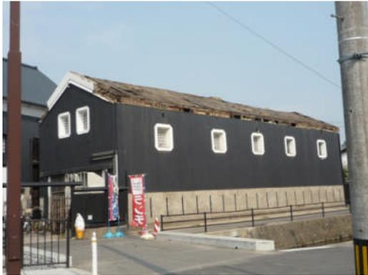
写真 5.2.2-2 屋根が崩落した土蔵
