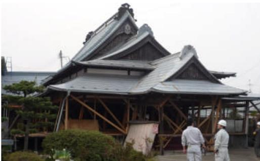
写真 5.2.2-17 大きく傾斜した寺社建築
