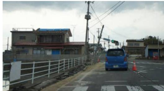
写真 5.2.6-26 傾倒した信号機
