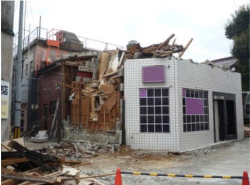
写真 5.2.6-13 大被害と推測される木造
