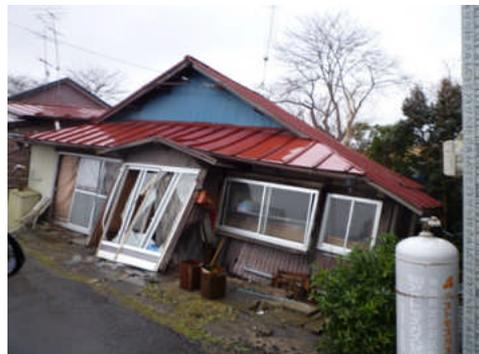
写真 5.2.1-4 地盤変状によると見られる被害
