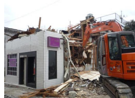
写真 5.2.6-14 写真 5.2.6-13 の解体撤去作業
