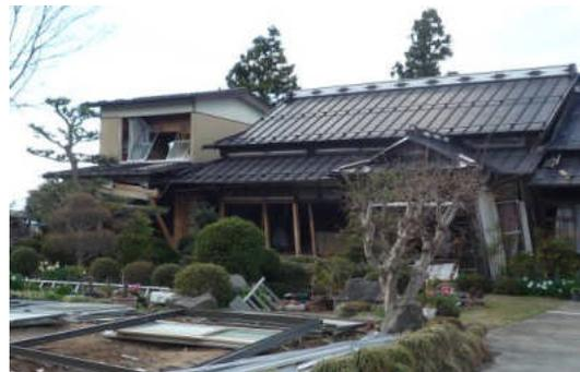
写真 5.2.3-2 残留変形の大きな住宅
