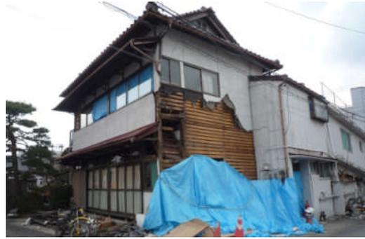
写真 5.2.6-10 階段室部分が崩壊した木造
