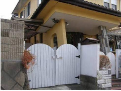
写真 5.2.8-11 地盤変状により大きく傾いた住宅
