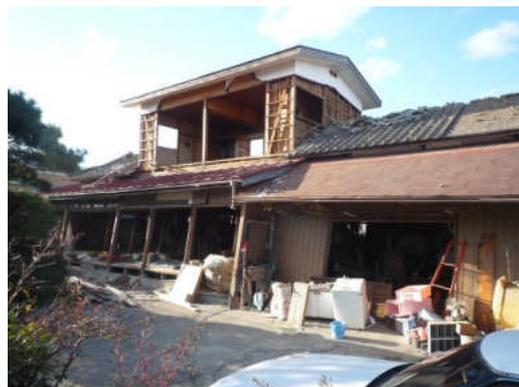
写真 5.2.3-8 1階が大きな残留変形の
