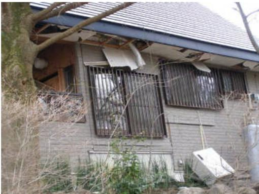
写真 5.2.7-13 軒裏天井の落下 (豊原乙地区)
