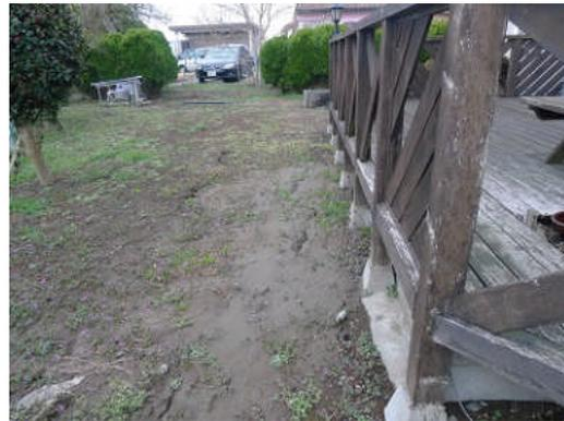
写真 5.2.12-4 液状化による噴砂痕
