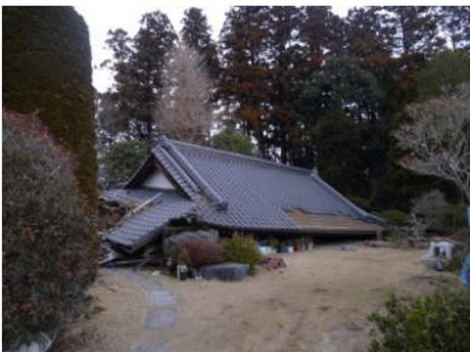
写真 5.2.9-1 1階が完全に崩壊した住宅
