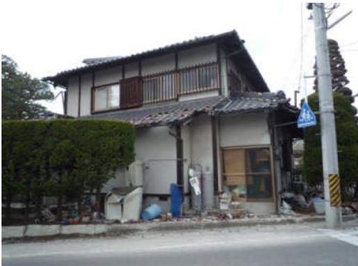
写真 5.2.6-15 屋根瓦の被害
