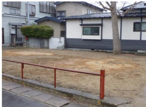
写真 5.2.1-3 液状化による噴砂痕
