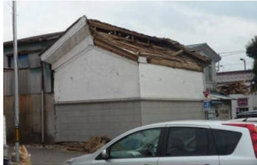
写真 5.2.6-12 屋根だけが崩壊した土蔵
