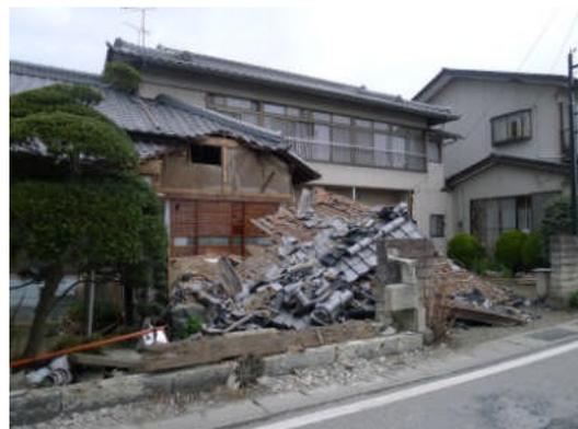
写真 5.2.9-2 住宅の玄関部分の崩壊
