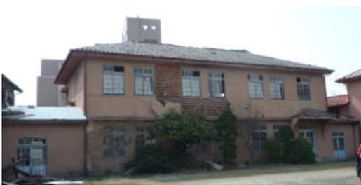
写真 5.2.2-9 屋根瓦と外壁に被害を受けた学校建築
