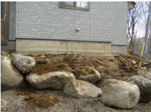
写真 5.2.7-7 外構の石の崩壊
