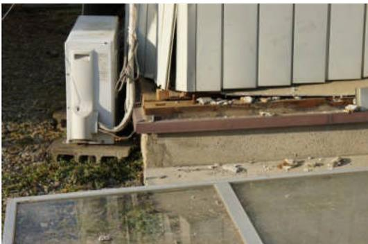
写真 5.2.7-21 写真 5.2.7-19 の柱脚接合部
