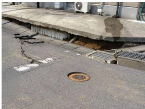
写真 5.2.8-8 宅地地盤の浮沈
