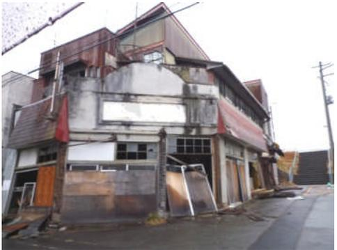
写真 5.2.1-12 老朽化した商店建築物の被害
