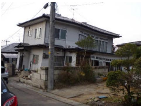
写真 5.2.5-6 地盤変状に伴う住宅被害
