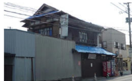
写真 5.2.2-14 2階の方が1階より残留変形が大きい店舗併用住宅
