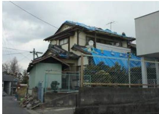
写真 5.2.6-20 屋根瓦の被害
