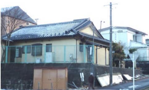
写真 5.2.5-11 棟瓦落下および塀の倒壊
