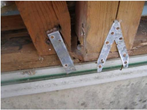
写真 5.2.7-9 写真 5.2.7-8 の柱脚及び筋かい端部
