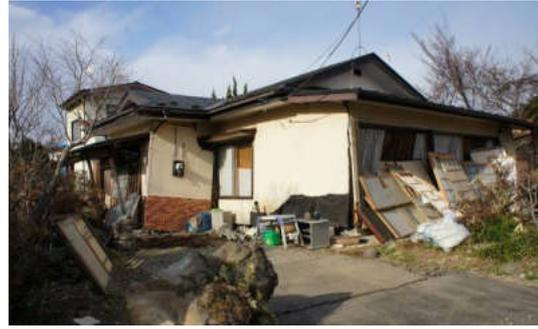
写真 5.2.7-18 地盤変状に伴う住宅被害
