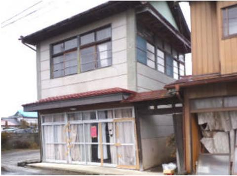
写真 5.2.1-7 町屋形式の住宅の被害
