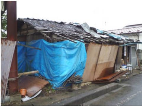
写真 5.2.1-9 老朽化した家屋の倒壊
