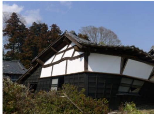
写真 5.2.10-2 大きく傾斜した納屋
