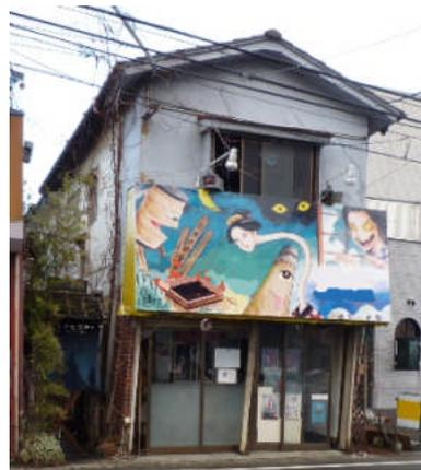
写真 5.2.5-10 残留変形の大きな木造
