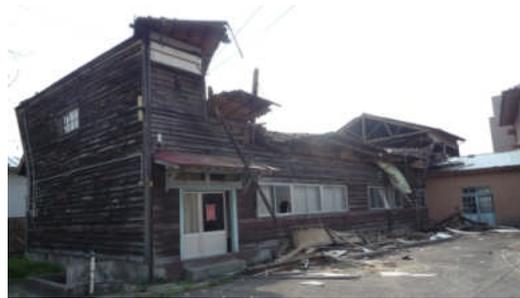
写真 5.2.2-10 2階が崩壊した学校建築
