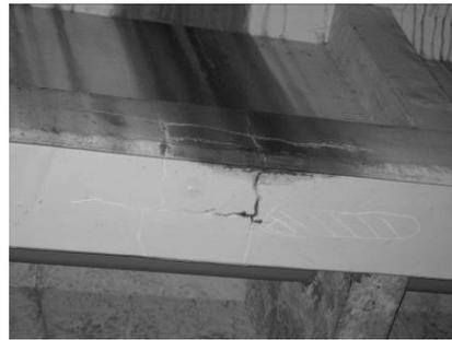
(d)鋼材腐食が懸念されるひび割れ
