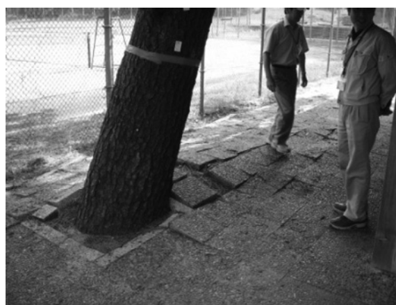
写真-7 舗装平板の持ち上げ
