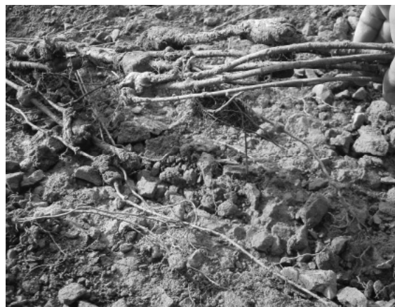
写真-5 路盤の隙間に合わせて瘤を作る
