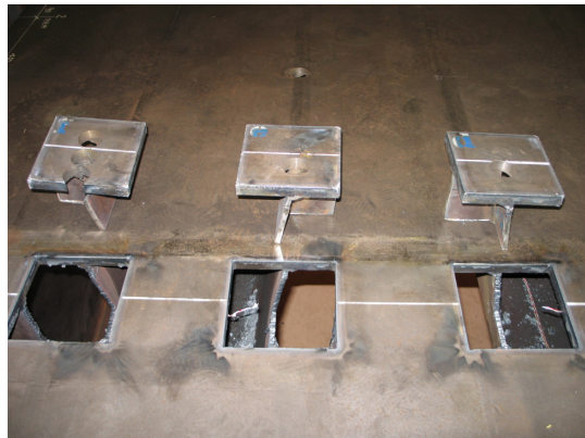
写真-4.3.5 横リブ交差部の切り出し調査の様子（U8側）
