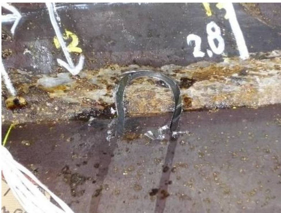
(b) コア切削完了（デッキ下面側より）
