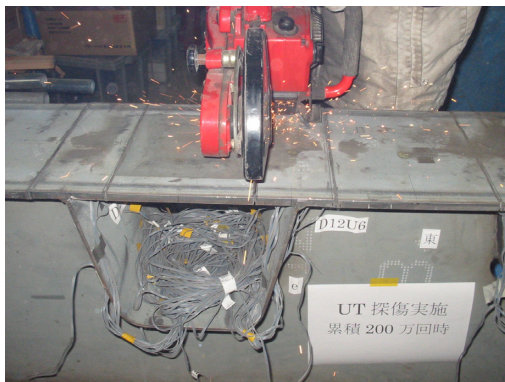
写真-2.2.6 切断状況①（エンジンカッター作業）
