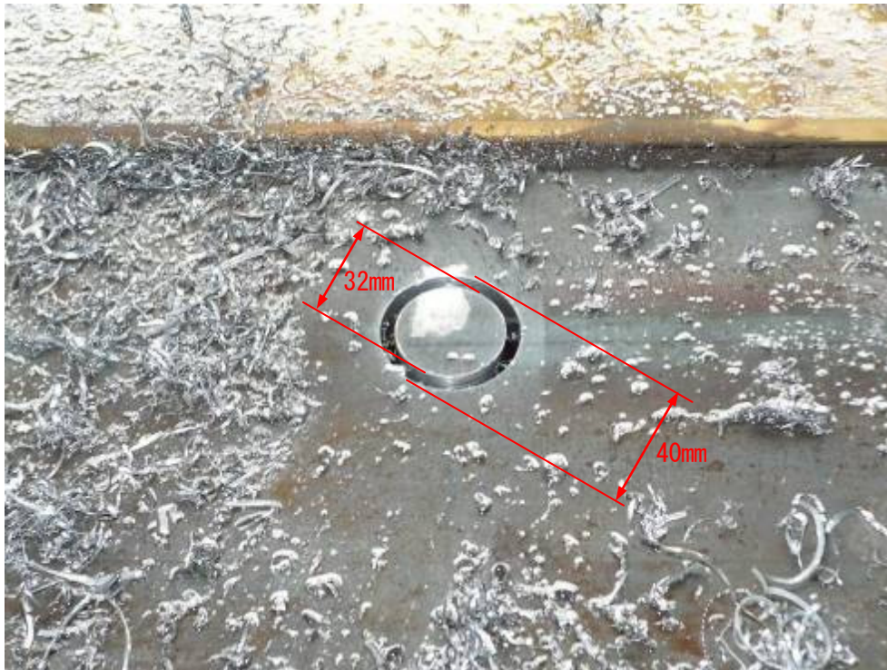
(a) コア切削完了（デッキ上面側より）
