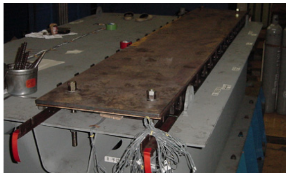
(c) ステップ3：ベニヤ板，敷き鋼板の設置
