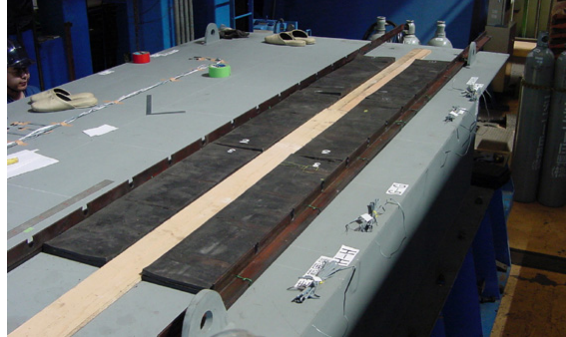
(a) ステップ1：ゴム板，コンパネ，アングルの設置
