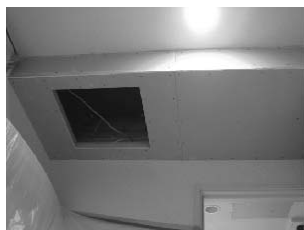
図4 換気設備用の下がり天井および点検口の設置
