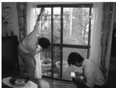
図6 既存サッシやドアの実況見分の様子
