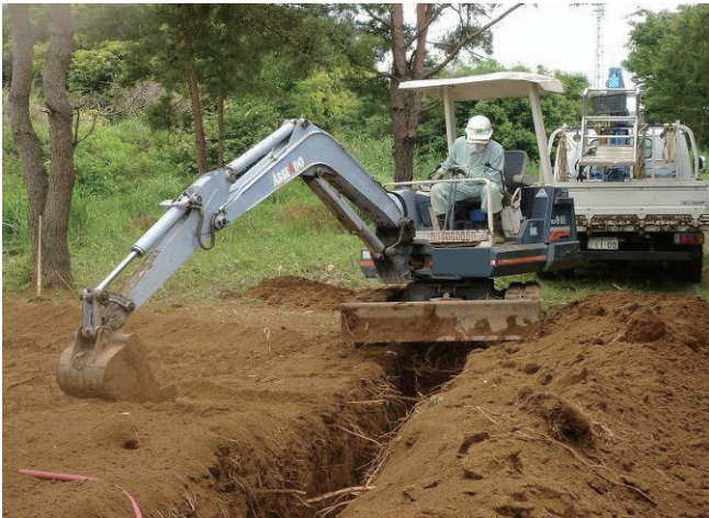
▲重機による掘削
