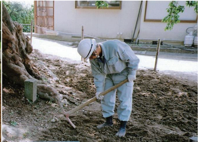
▲人力による掘削
