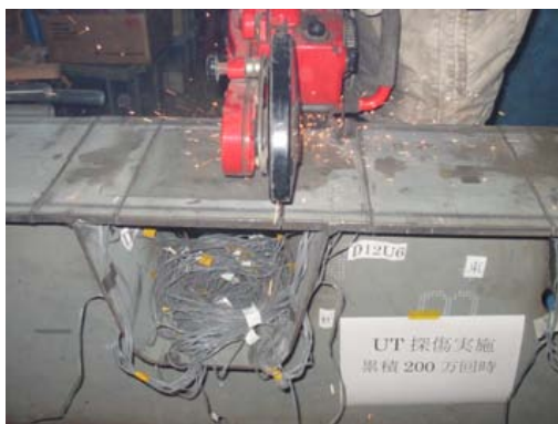
写真 3.1.6 切断状況① エンジンカッター作業
