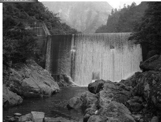
光岩砂防堰堤
