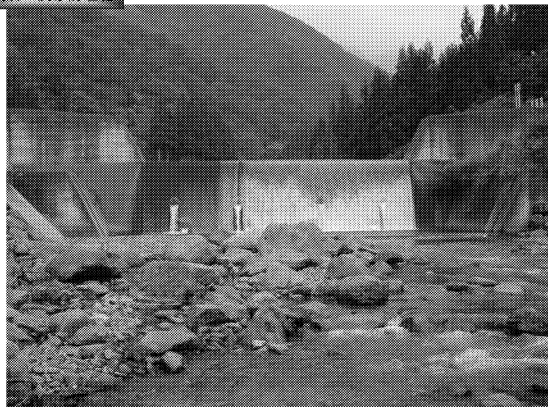
高石上流砂防堰堤
