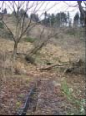
土砂で埋まった水路
