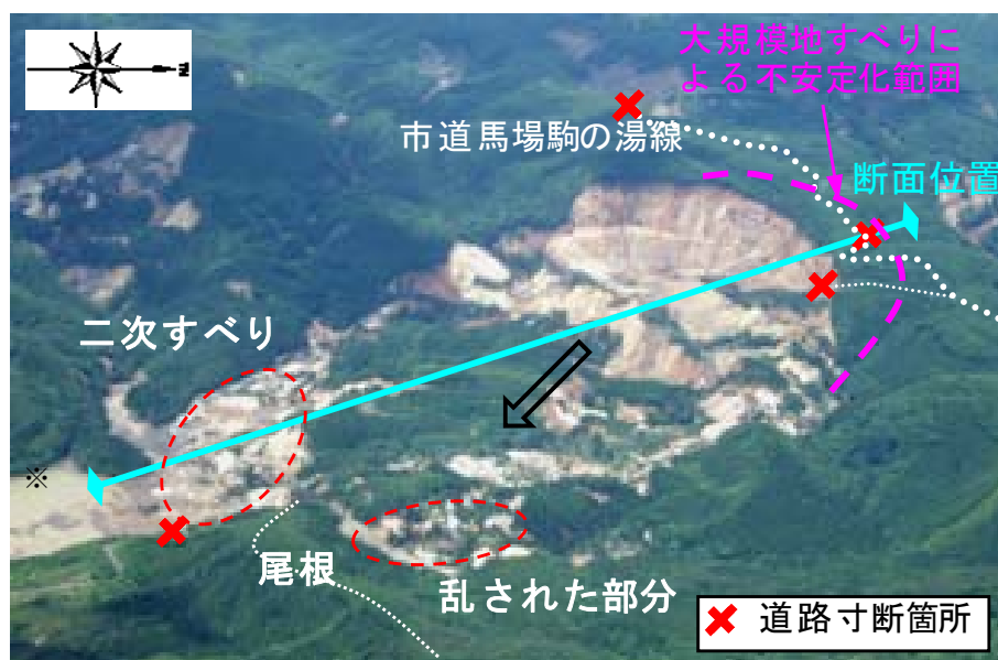
写真-3 大規模地すべり全景(6/15 空撮)
