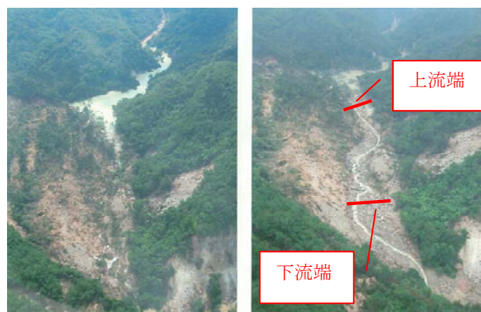
写真-5 越水による侵食前後の沼倉裏沢地区の天然ダムの様子 (左：6/20 撮影、右：6/21 撮影)
