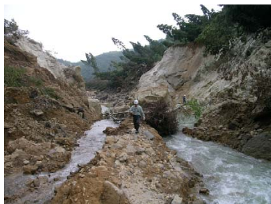
写真-6 天然ダム上流端の状況 (7/3 撮影、下流を望む)
