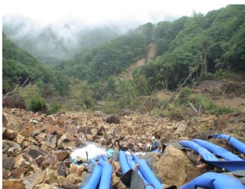
写真-4 湯ノ倉温泉のポンプ排水（7/8 撮影）
