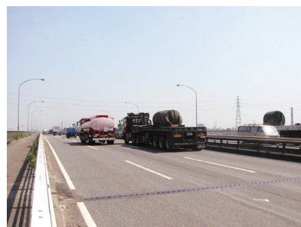
写真解 4.3-6 鉄鋼荷役の多い交通状況例
