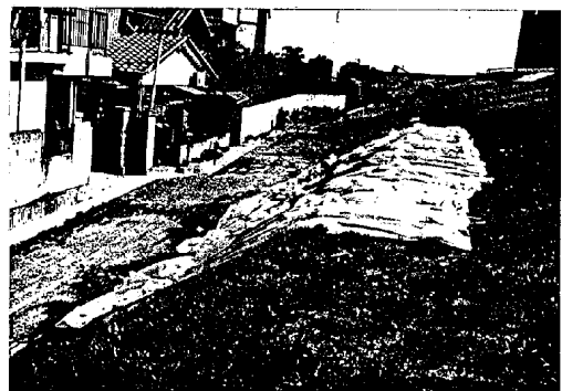
図-5.2 被災状況（江戸川 No. 6）
