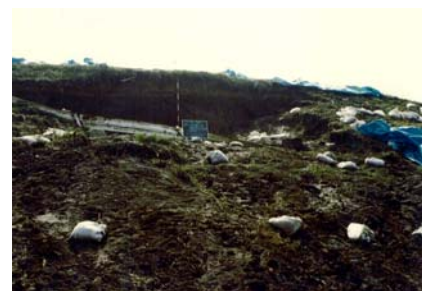
図-3.14 被災状況（荒川 No. 12）
