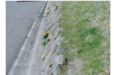
■天端工のコンクリート部分を若干低く施工し、その上部に土を入れ植栽することによって天端のコンクリートを隠している。(出典27-3)
