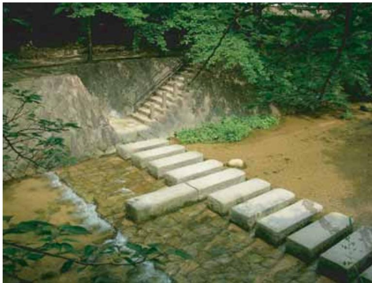
■堰堤(床止工)周辺に設置されている飛び石(出典4-13)
