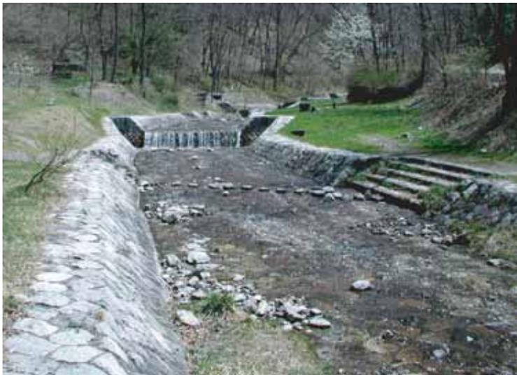
■昭和61年より始まった砂防環境整備事業では、フランス階段工上流部の砂防施設も巻天端で整備するなど、下流のフランス階段工を意識したデザインとなっている。(出典19-16)
