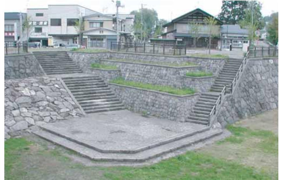
■秋田県・横手川(出典27-29) 数多くの端部処理によって階段が設けられている。
