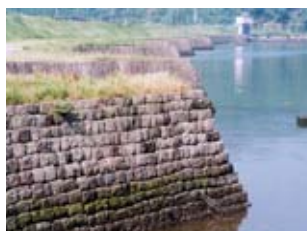
36 川内川・長崎堤防
