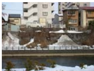
02 北上川・石積護岸
