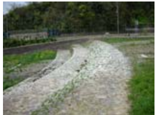
78 大谷川砂防堰堤
