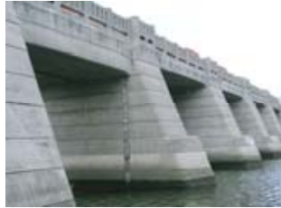
45 荒川・岩淵水門
