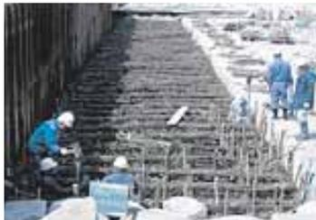
■堰下流に設けられた粗朶沈床(出典16-16)
