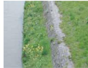
■天端を巻天端として天端コンクリートが見えないようにしている。さらに、その上に植物が繁茂し景観的に馴染んでいる。(出典27-4)
