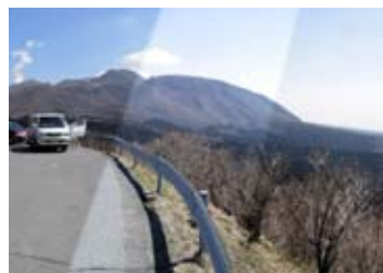
瀬の本（亜鉛メッキのガードレール）
