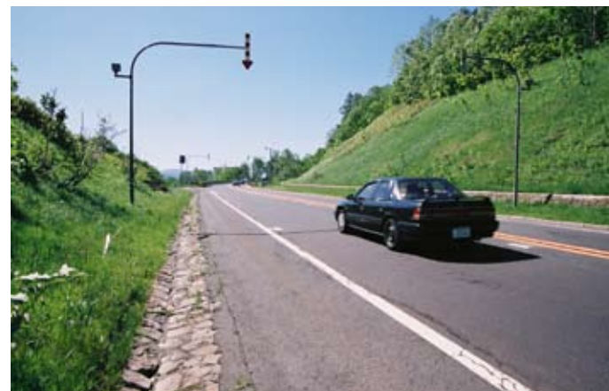
現地発生材を利用した皿型側溝と擁壁
