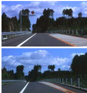
山武杉すり付け区間
