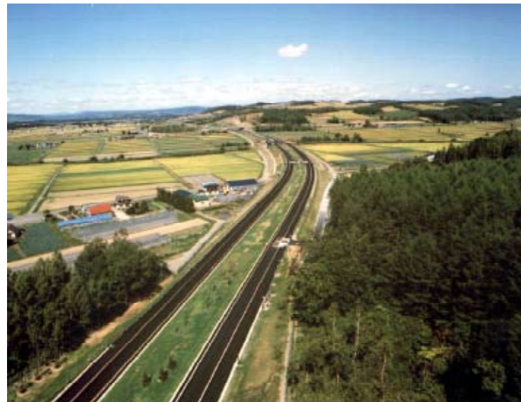
暫定施工区間の外側2車線運用
