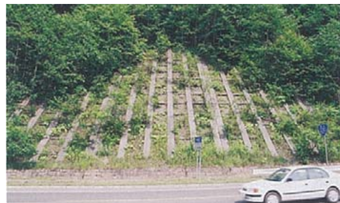
横フレームの印象を弱くすることにより法枠の存在印象を弱めている
