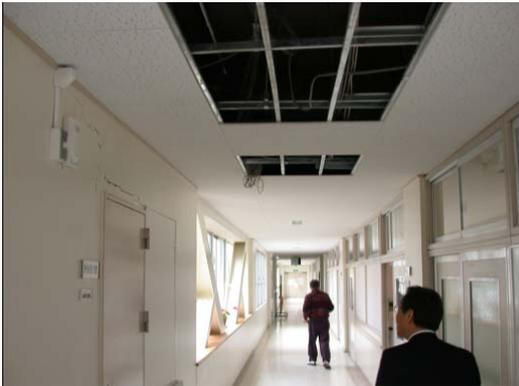
写真-6.9 校舎棟の廊下天井パネルの落下被害
