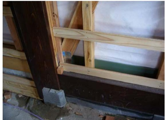
写真-4.111 筋かい端部には所定の金物
