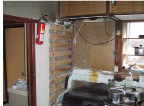
写真-4.87 仕上げ材の剥落
