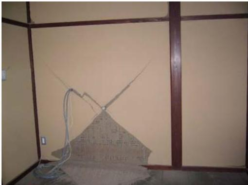
写真-4.104 せん断破壊した土塗り壁
