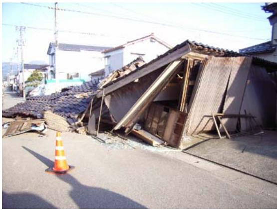
写真-4.7 1階車庫か倉庫の建物の倒壊
