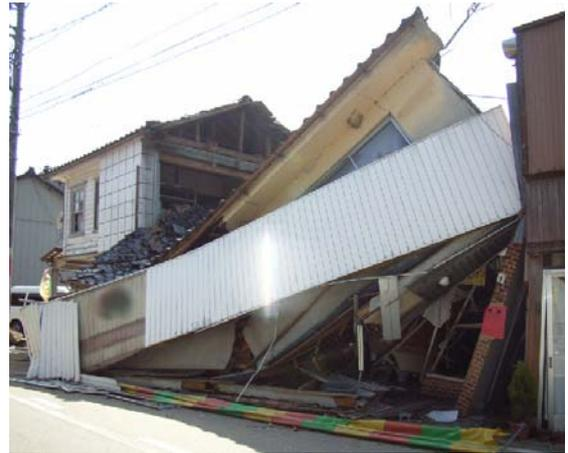
写真-4.22 倒壊した店舗併用住宅
