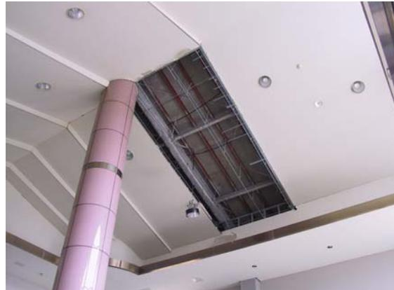
写真-7.40 エントランスホールの天井の被害
