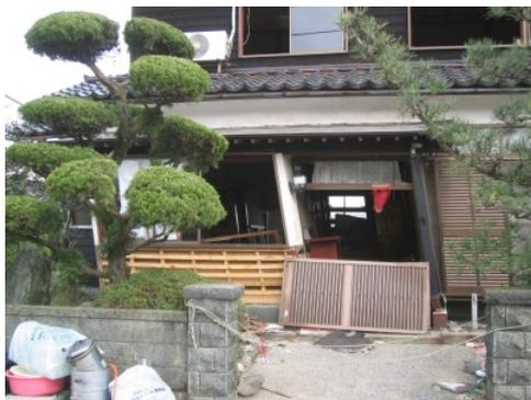
写真-4.84 外壁モルタルの剥落
