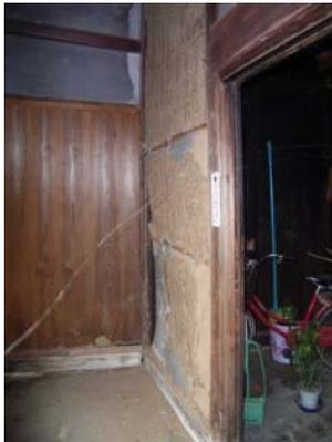
写真-4.124 土壁の剥落
