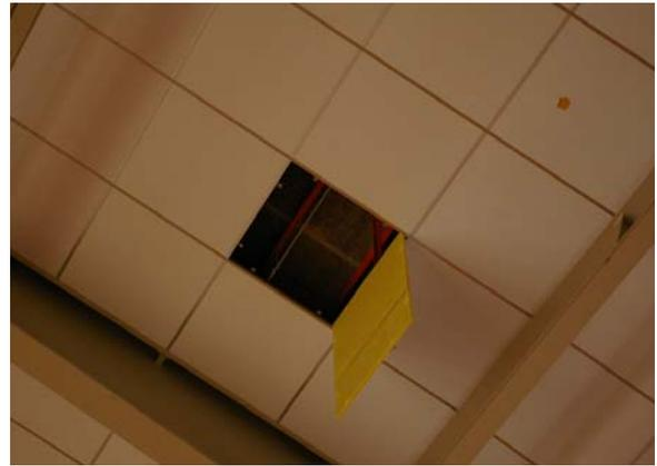
写真-7.27 被災直後のランニングロード上部の様子 写真-7.28 脱落しかけたガラスウールボード
