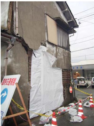
写真-4.129 モルタル壁の脱落
