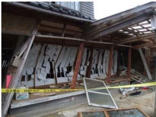
写真-4.143 大きく傾いた柱
