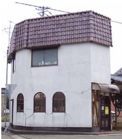
写真-4.47 躯体の腐朽が確認された店舗
