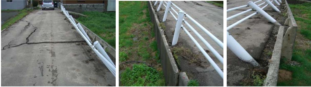
写真-8.11 L型コンクリート擁壁の被害例
