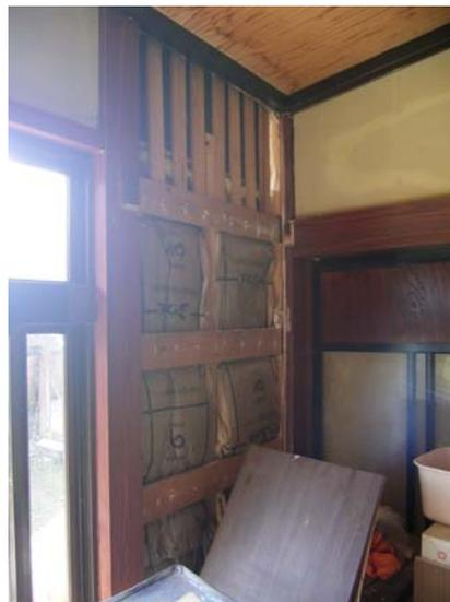
写真-4.93 壁の被害（ラスボード落下）
