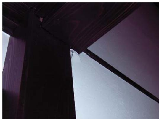
写真-4.162 内装ボードの隅部の破壊
