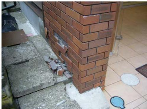
写真-4.80 店頭西側脚部の外装の破損
