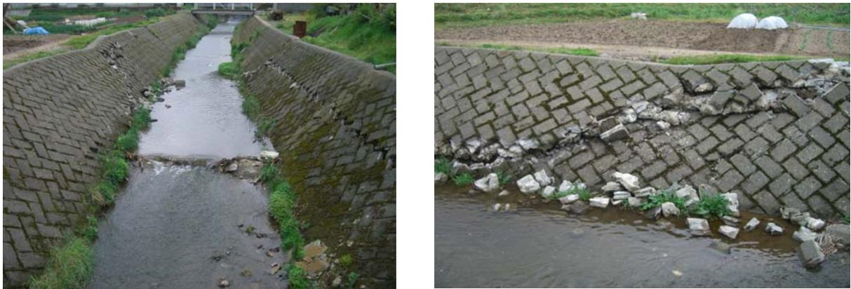
写真-8.12 ブロック積み擁壁の被害（門前道下地区）
