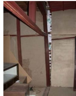
写真-4.128 梁の抜け出し
