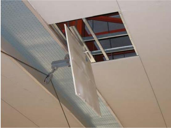
写真-7.24 脱落しかけた天井材
