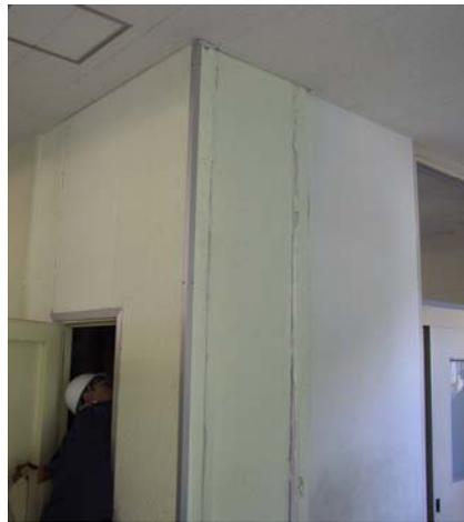
写真-5.11 ALC パネルの目地割れ
