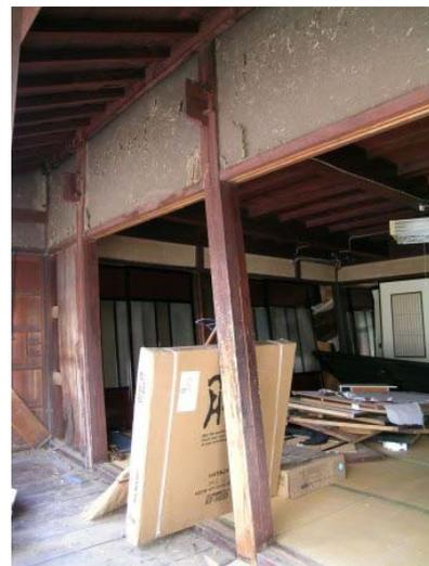
写真-4.117 2階床高さで通し柱折損
