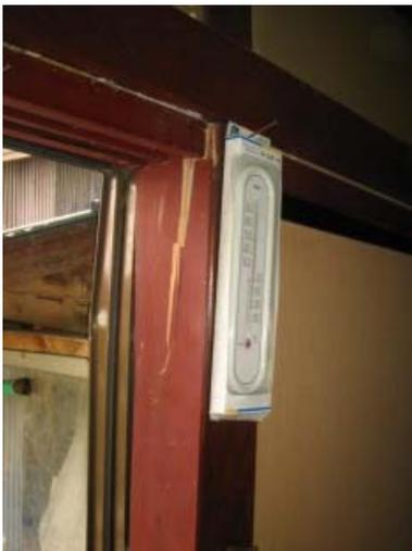
写真-4.88 柱の割裂
