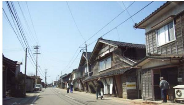
写真-4.30 道路側に大きく傾斜した家屋群
