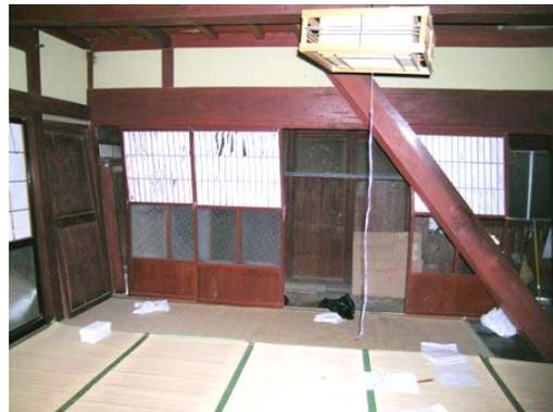
写真-4.148 通り庭内側の傾斜と柱折損
