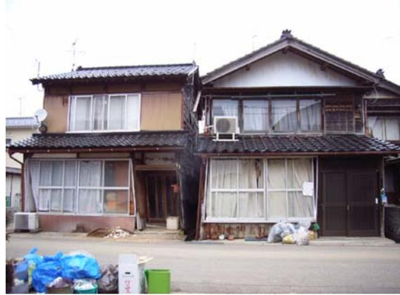
写真-4.46 衝突して外側へ傾いた建物
