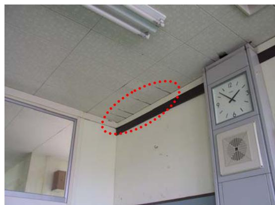
写真-5.8 間仕切り壁がずれた跡 (廊下側)
