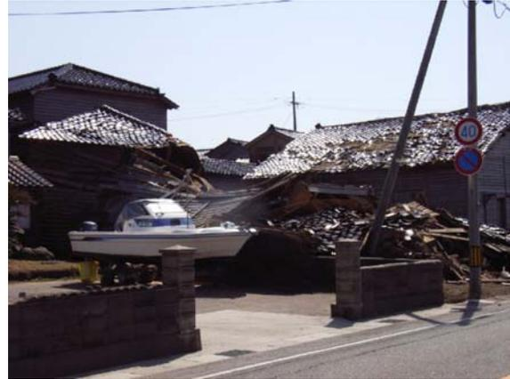
写真-4.34 倒壊した納屋又は倉庫
