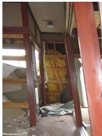
写真-4.85 内壁仕上げ材の剥がれ
