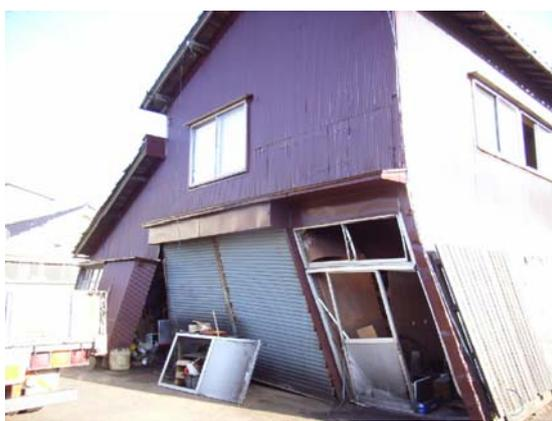
写真-4.2 倒壊寸前のチップ工場の倉庫
