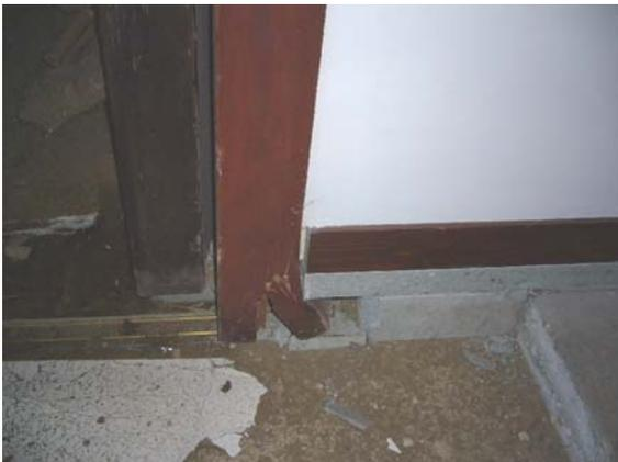
写真-4.106 基礎と土台のずれ
