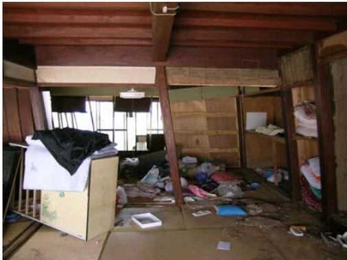
写真-4.116 内部。柱の折損、壁の脱落。
