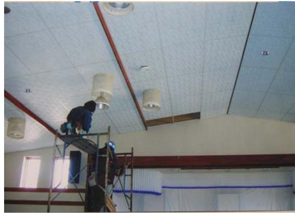
写真-7.42 天井補修工事の様子
