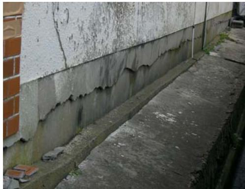
写真-8.5 ブロック基礎の被害例
