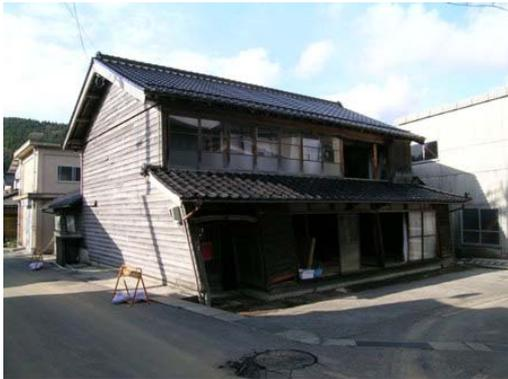
写真-4.114 全景。左（西）に残留変形大
