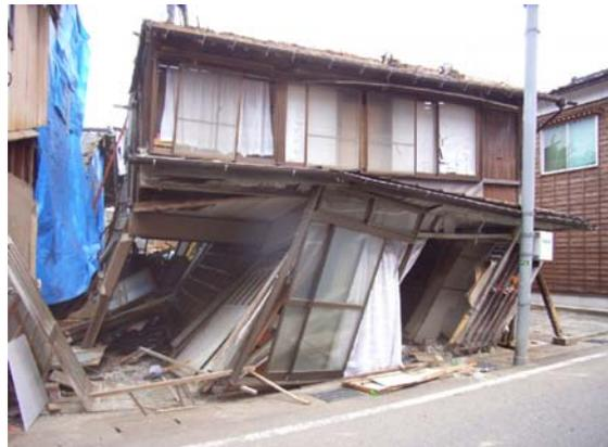
写真-4.44 倒壊寸前の建物
