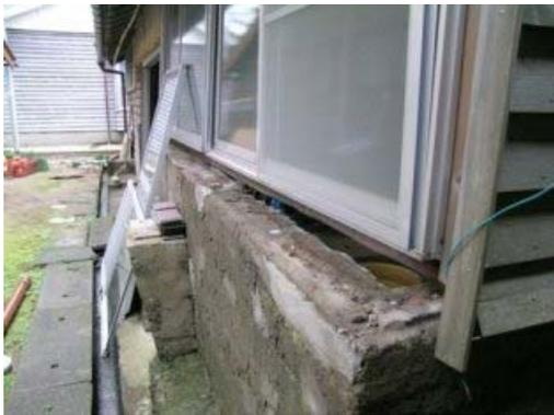
写真-4.147 背面側(コンクリート上で滑る)
