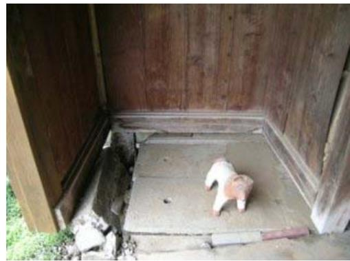
写真-4.146 外壁が道路側(左)に滑る
