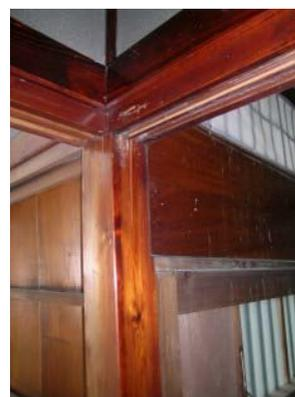
写真-4.61 柱の亀裂
