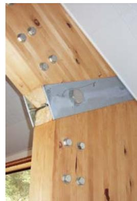
写真-4.168 接合部の被覆材の脱落
