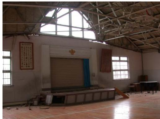
写真-6.12 講堂の妻壁部の被害
