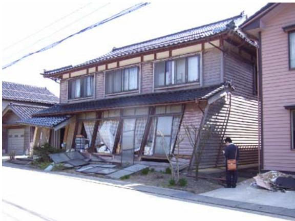
写真-4.29 通りの方向の残留変形が大きい住宅
