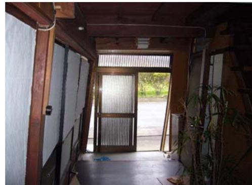
写真-4.134 極めて大きい残留変形角
