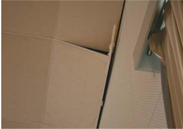
写真-7.33 妻壁際で脱落しかけた天井部材
