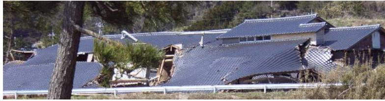
写真-4.36 鹿磯地区で倒壊した製材工場
