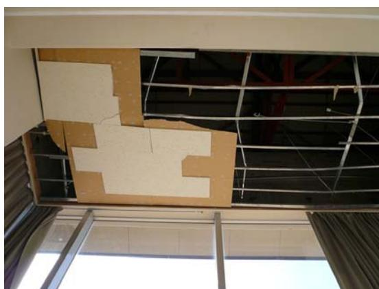
写真-7.3 捨て張り工法による天井の被害
