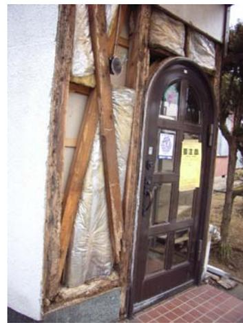
写真-4.48 木造躯体の腐朽
