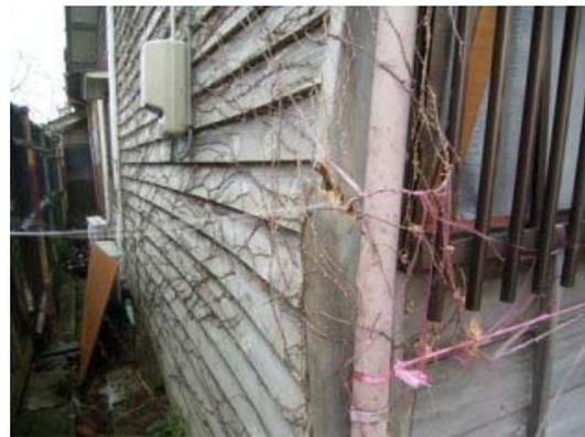
写真-4.119 南東隅の柱の折損
