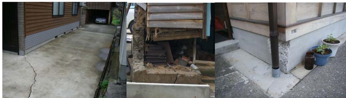
写真-8.6 コンクリート基礎の被害
