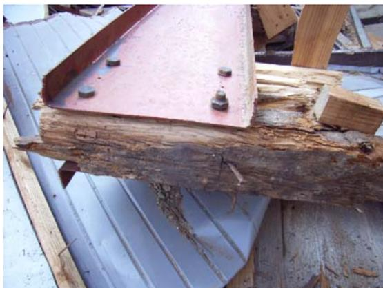
写真-4.4 左の家屋の鉄骨梁と木材柱の腐朽
