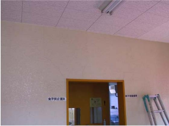
写真-5.16 トイレ入口の壁の亀裂
