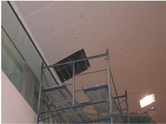
写真-7.30 グラスウールボードが脱落した箇所
