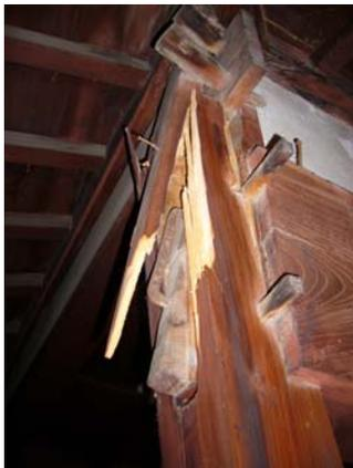
写真-4.74 通し柱を折った桁
