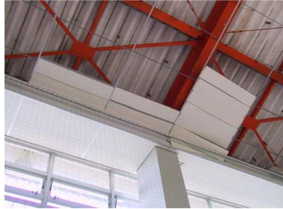
写真-7.14 ずれたり脱落しかけたりしている
