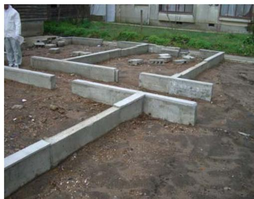
写真-8.8 アンカーボルトが乏しい基礎
