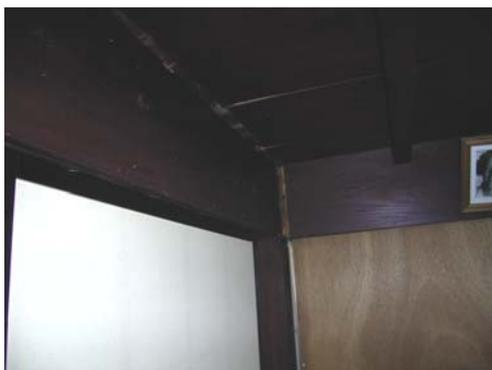
写真-4.68 改装時に設置された合板壁
