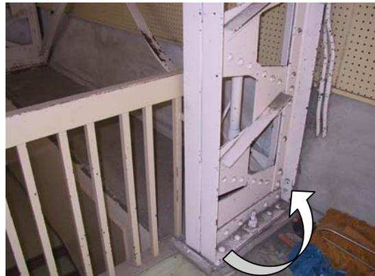
写真-5.5 柱脚部の回転
