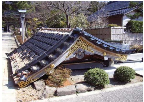
写真-4.18 倒壊した手洗い場の東屋
