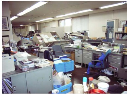
写真-6.4 室内のオフィス家具の転倒被害
