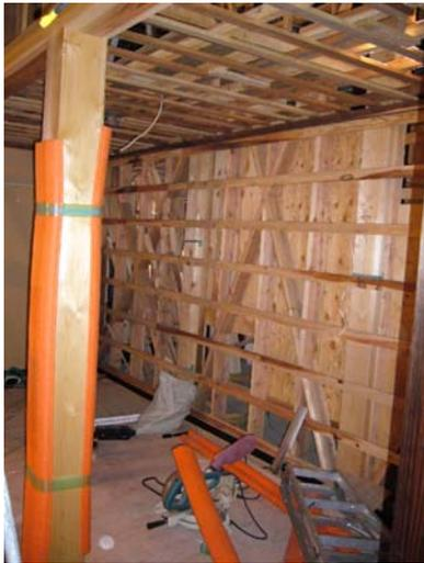
写真-4.110 筋かいが多数施工されている
