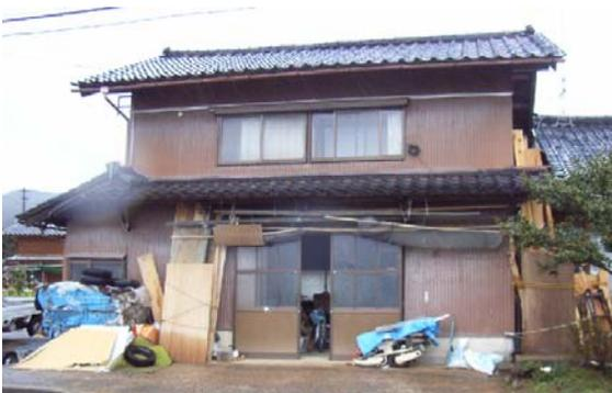
写真-4.55 多少の残留変形が残る家屋
