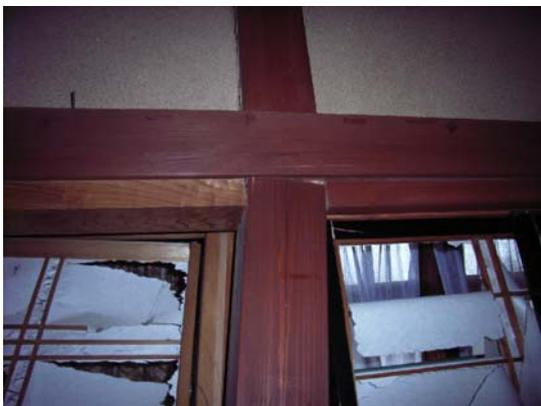
写真-4.135 柱の折損
