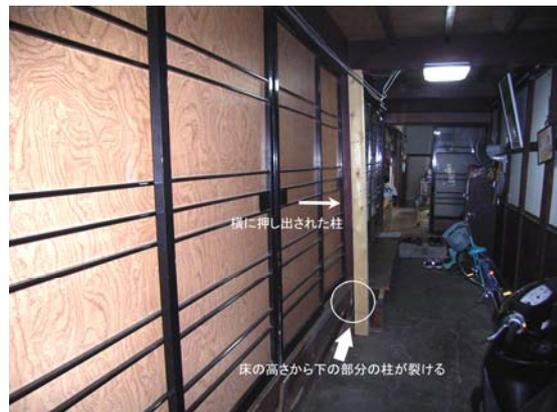
写真-4.67 床から下が折れた柱
