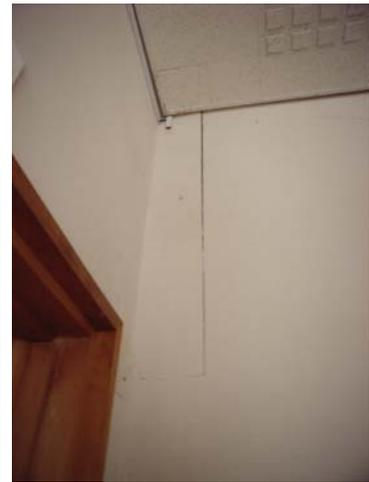
写真-4.166 ビニル壁紙の亀裂
