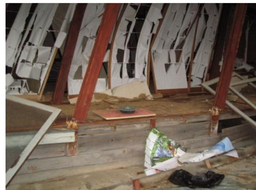
写真-4.144 下端部付近での柱の折損
