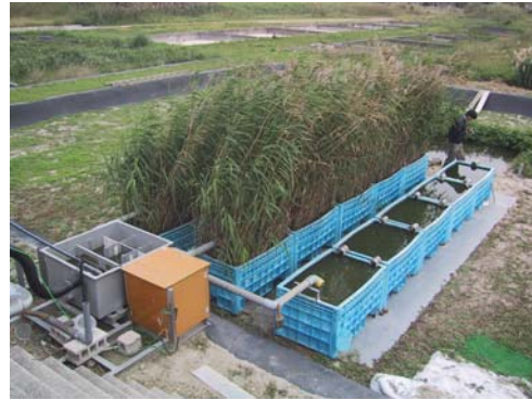
写真-34 植生帯全体
