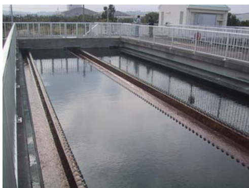
写真-27 浄化センター最終沈殿池
