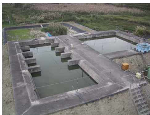
写真-28 ラグーン実験施設全体
