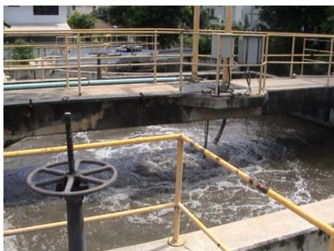
写真-19 ホイクアン処理場の曝気槽
