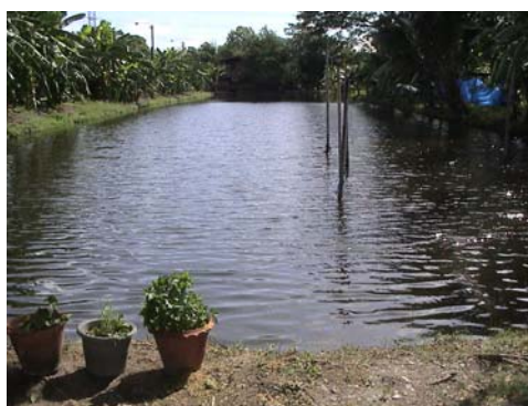
写真-16 ラグーン(沈砂池)
