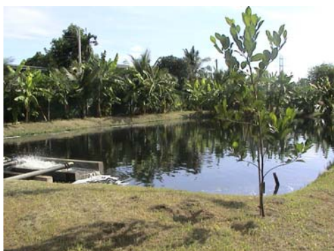
写真-13 曝気式安定化池の調整池
