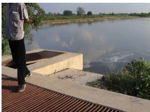
写真-9 ラグーンへの流入口付近
