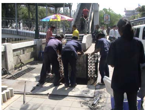
写真-7 インターセプター管の蓋開け
