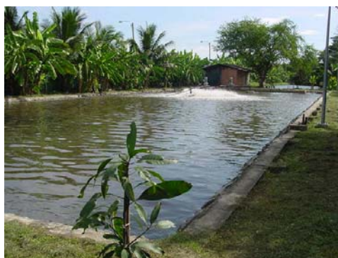
写真-14 曝気式安定化池
