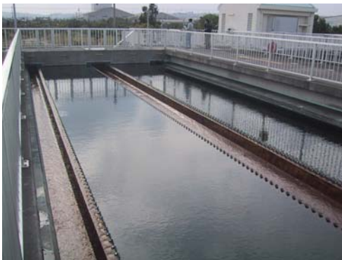
写真-27 浄化センター最終沈殿池
