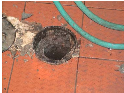
写真-6 汚泥引抜用の穴(家庭)
