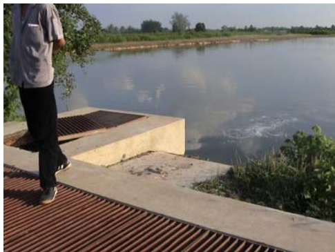
写真-9 ラグーンへの流入口付近
