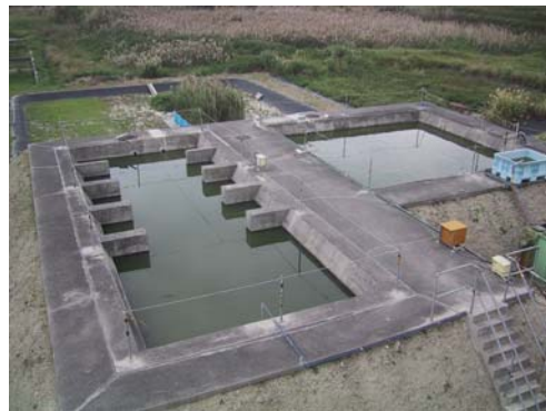
写真-28 ラグーン実験施設全体
