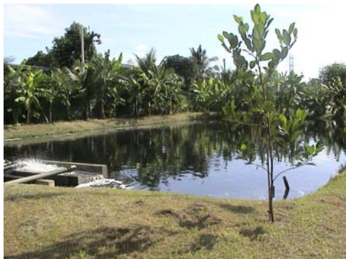
写真-13 曝気式安定化池の調整池
