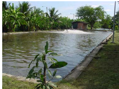
写真-14 曝気式安定化池
