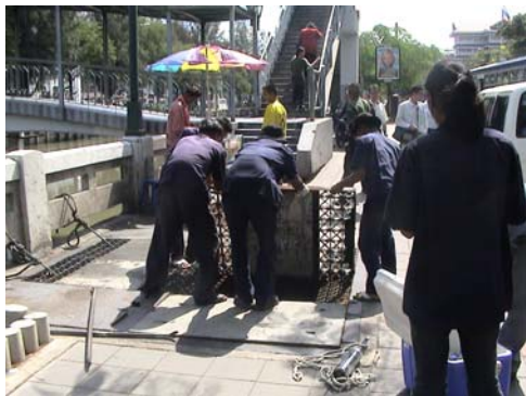
写真-7 インターセプター管の蓋開け
