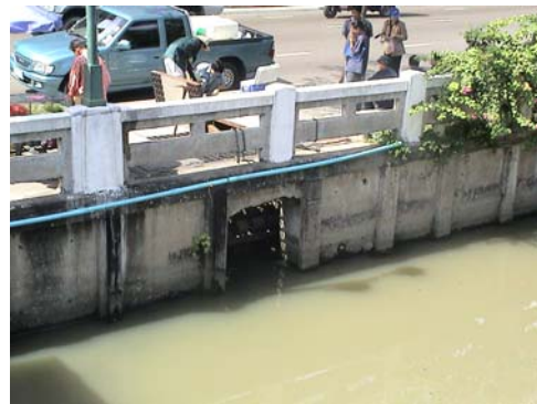
写真-8 洪水時の下水排出ゲート
