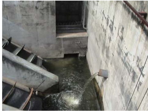
写真-18 流入水の引上げ
