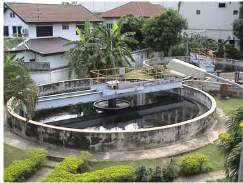
写真-20 ホイクアン処理場の最終沈殿池
