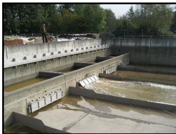
写真 4 雨水滞水池におけるフラッシング
