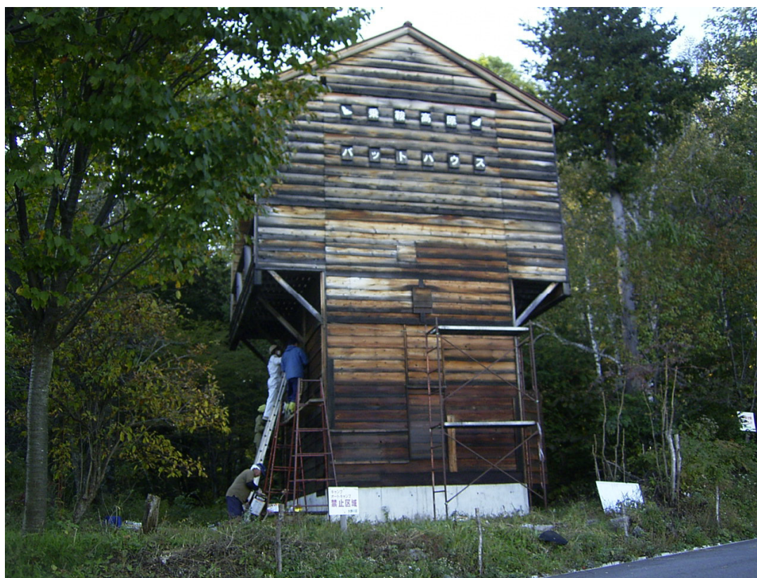
図Ⅲ. 1. 1 バットハウスの修繕作業(長野県安曇村乗鞍高原クビワコウモリのバットハウス)
