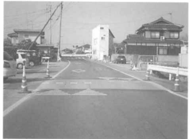
写真-1 生活道路にハンプを設置した例
