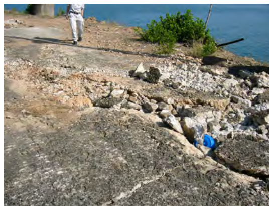
写真-3.16 主防波堤の舗装状況
