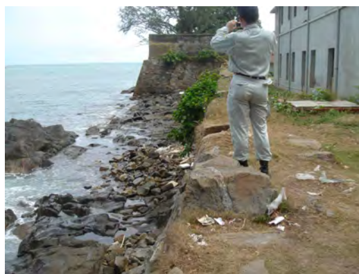
写真-3.19 フォート地区東北部の城壁の状況
