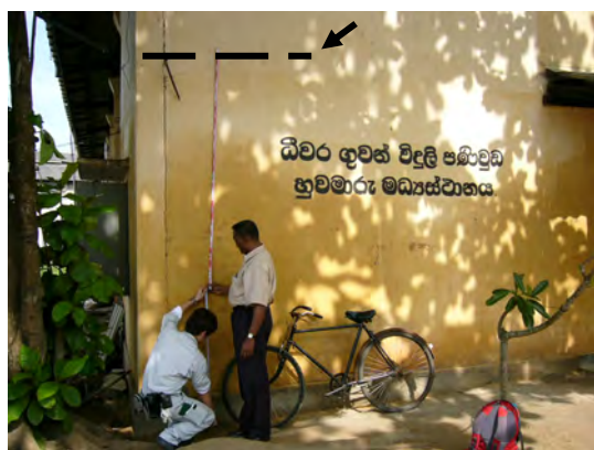
写真-3.17 ゴール漁港における浸水痕跡(点線位置)
