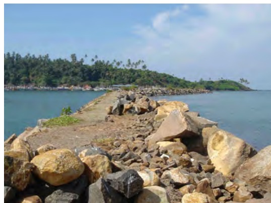
写真-3.23 Mirrissa 漁港防波堤の状況
