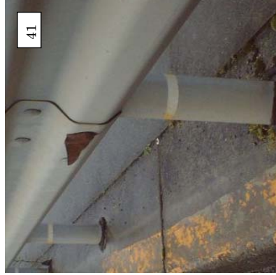
継ぎ目（端部継ぎ目）
