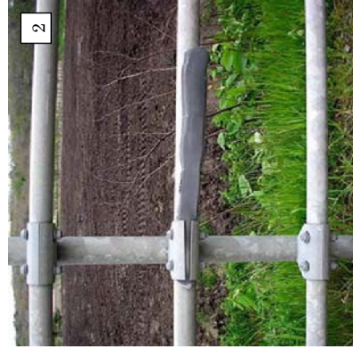
継ぎ目（端部継ぎ目）
