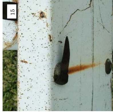
ボルト部（端部ボルト）
