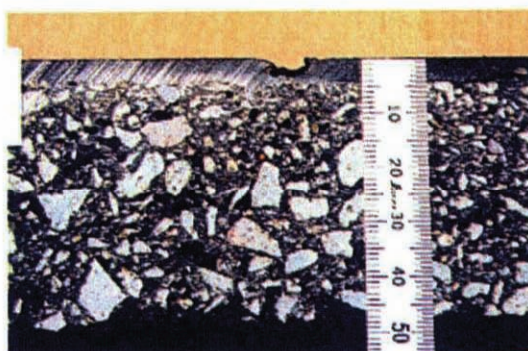
ピンホール部 細かい空隙が存在
