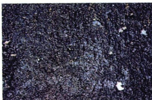
剥離面は湿潤だがアスファルト剥離は見られない
