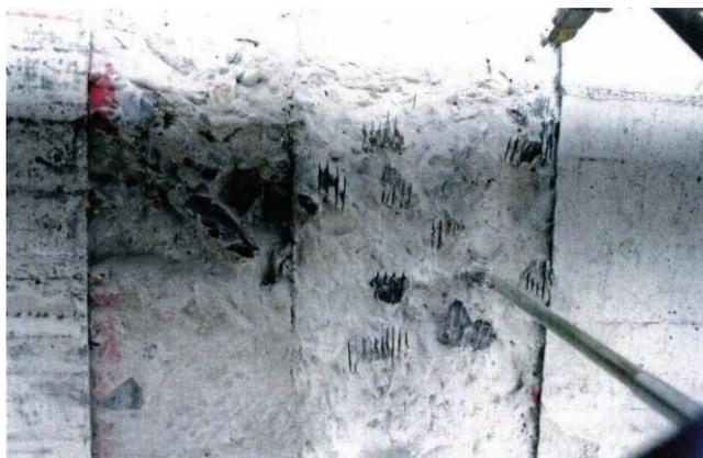
写真 3.10 補修部骨材カッター処理
