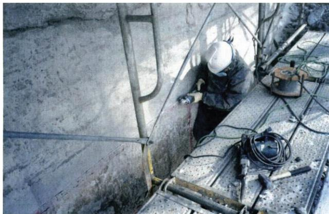
写真 3.8 補修部カッター処理
