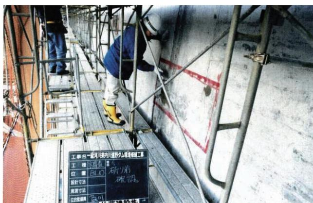
写真 3.7 補修部検査
