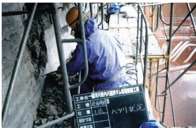
写真 3.9 補修部ハツリ処理
