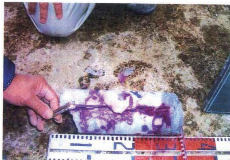
コアー抜き調査。同上フェノールフタレイン削孔面塗布後。
