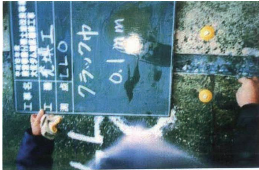
ハツリ後クラック調査(LL0+0m)。開口幅0.1mm。
