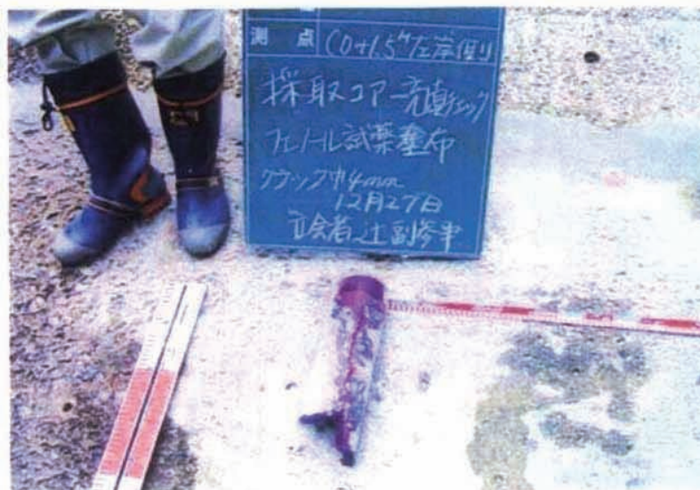
コアー抜き調査。同上コアフェノールフタレイン塗布後。
