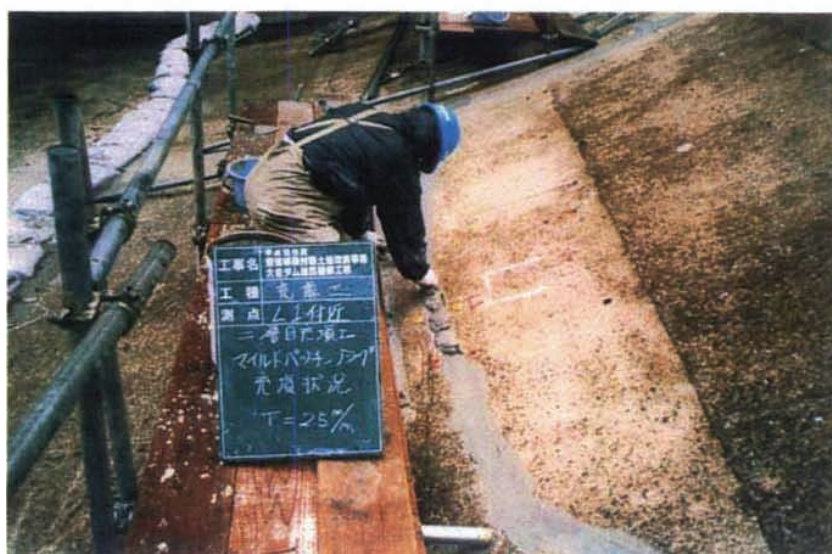
施工状況 仕上げ充填(2層目)(L1+0m付近)。
