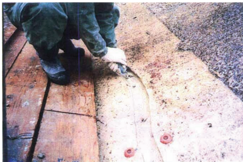
施工状況 注入工シリンダー残液排出(R1+0m付近)。
