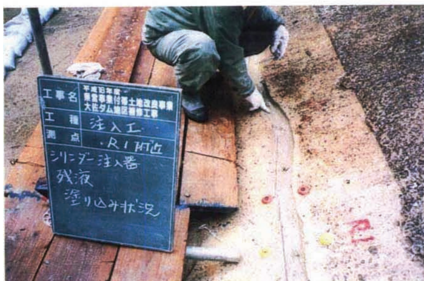
施工状況 注入工シリンダー残液塗りこみ(R1+0m付近)。
