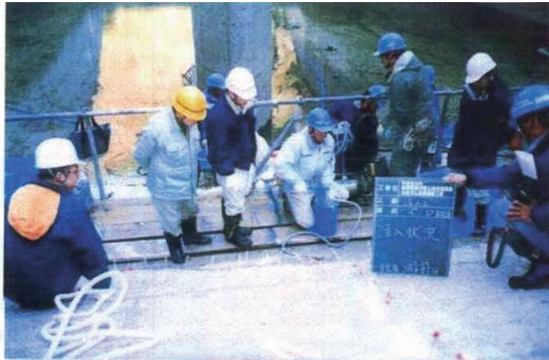
施工状況 ケミカルポンプによる 注入工(中央部)。
