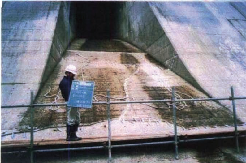
施工状況 シリ ンダー注入器によ る注入工(中央部)。
