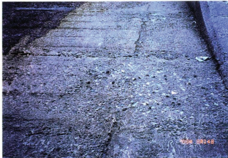
常用洪水吐 下部左岸側
