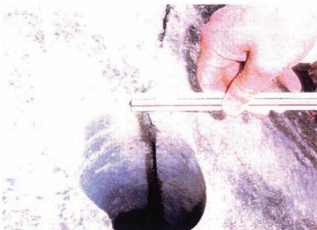
写真 2.6 左岸縦継目詳細写真
