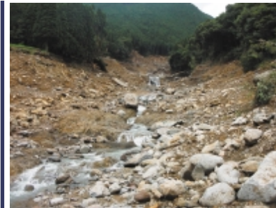
② 土石流の流下跡
