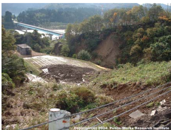
写真 9.2.7 崩壊先端部の状況
