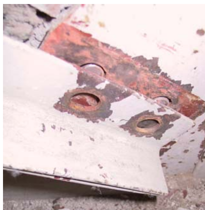
写真 10. 3. 20 ブレース材端部ボルト破断 (11)
