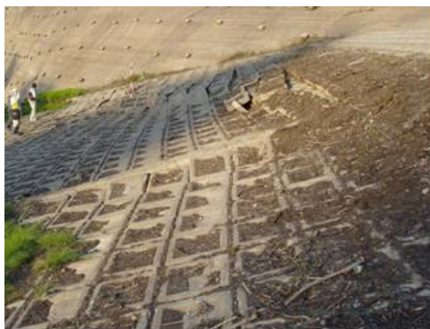
写真 8.15 上流のり面の変状（川西ダム）
