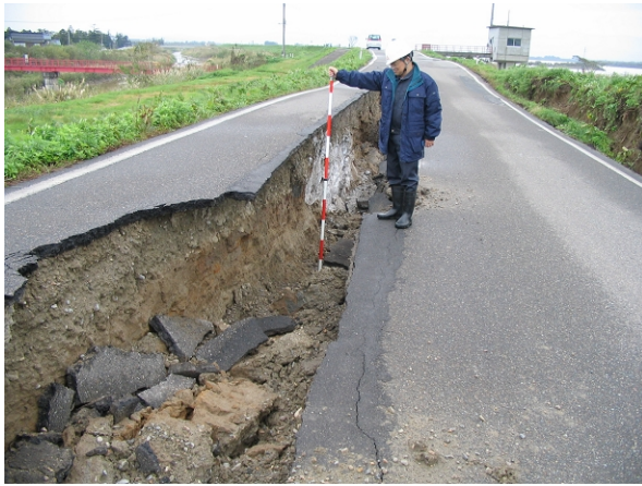
(a) 堤防天端の縦断亀裂と段差
