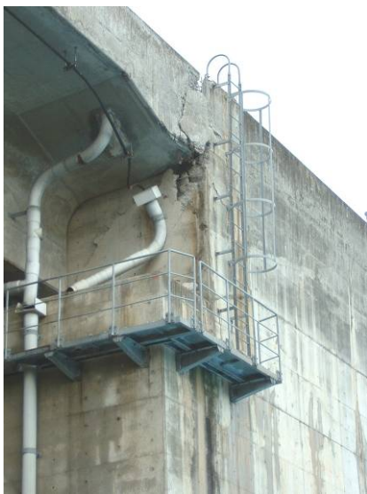
写真 9.1.50 桁衝突による高欄および橋台の損傷（芋川橋）
