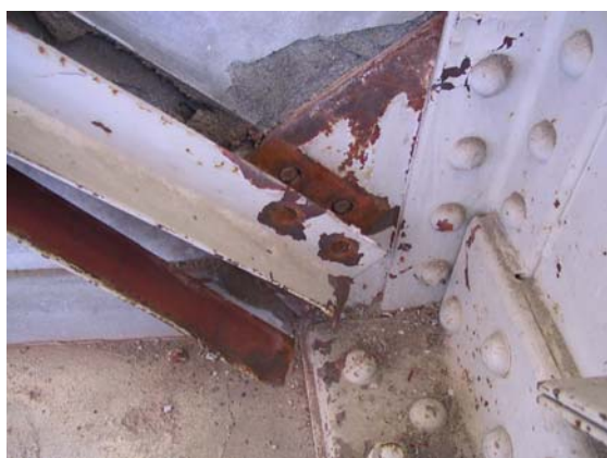
写真 10.3.24 ブレース材端部ボルト破断 (22) 写真 10.3.25 間柱脚部ボルト破断、ずれの跡 (24)
