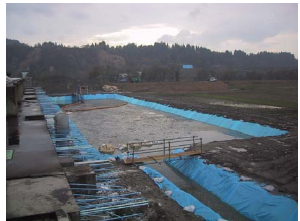
写真 6.10 仮設沈殿池 (堀之内浄化センター)
