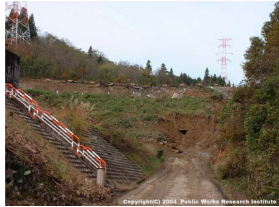
写真 9.2.6 アンダーパスの道路は崩壊土により閉塞
