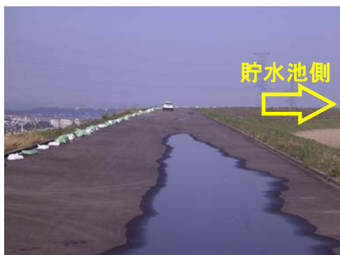
写真 8.5 天端舗装面の傾斜（新山本調整池）
