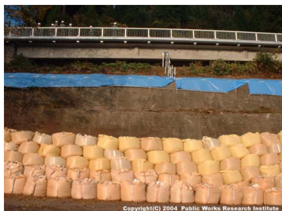
写真 9.2.15 被災した重力式擁壁
