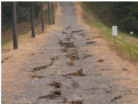
写真 8.1 天端亀裂近景 (浅河原調整池)
