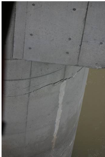
写真 9.1.11 橋脚に生じたひびわれ(P6 橋脚)
