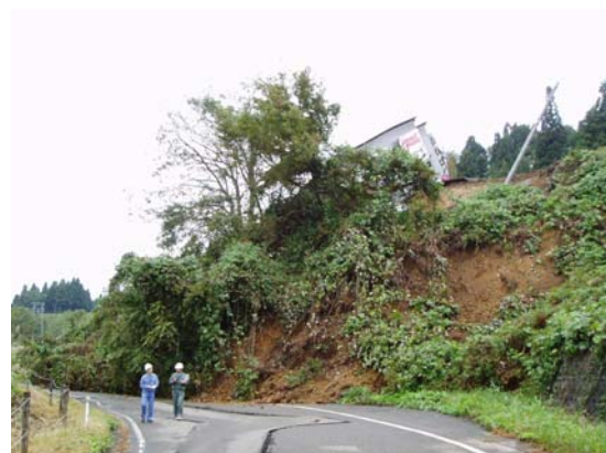
写真 9.2.62 強風化した基盤岩の一部をすべり面にしたやや深い崩壊 (左の写真の約 100m 北西)
