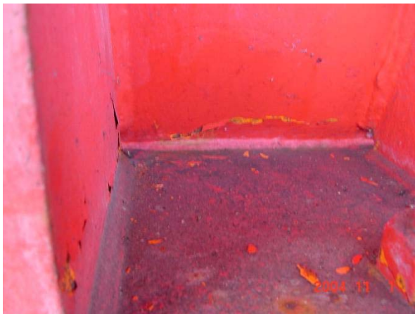
写真 9.1.32 支点上の桁ウェブ面のはらみ (堀之内橋)
