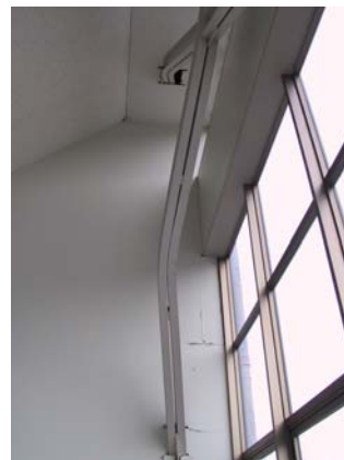
写真 10. 3. 33 ブレース材の座屈(40)
