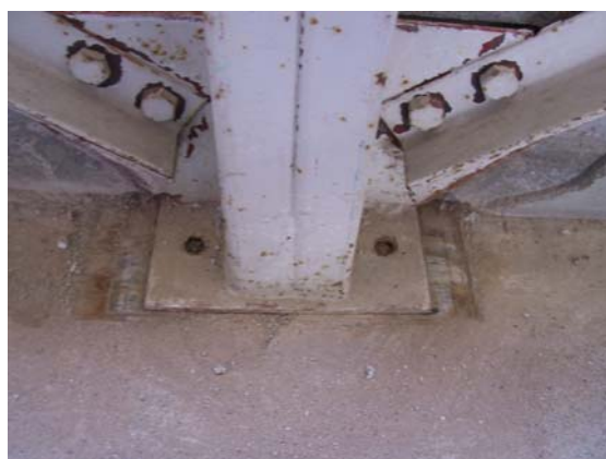
写真 10.3.24 ブレース材端部ボルト破断 (22) 写真 10.3.25 間柱脚部ボルト破断、ずれの跡 (24)
