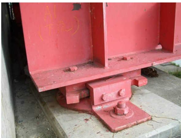
写真 9.1.56 可動支承上沓の変位制限ストッパー部の変形（宇賀地橋）
