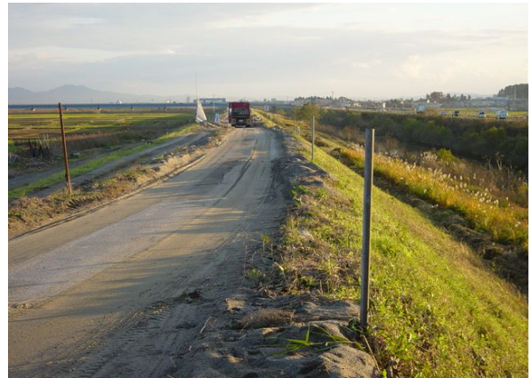
(a) のり肩を残して天端が沈下
