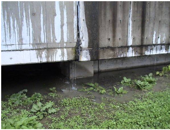
写真 6.1 水処理施設のひび割れ
