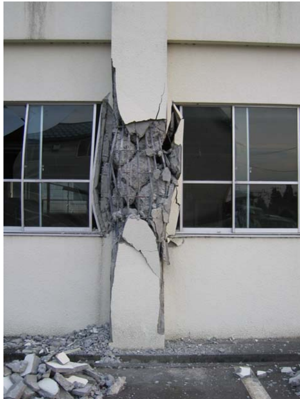
写真 G10. 3 鉄筋コンクリート造建築物の被害（短柱のせん断破壊）
