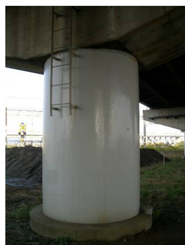
写真 9.1.2 上り線橋脚の鋼板巻立て補強
