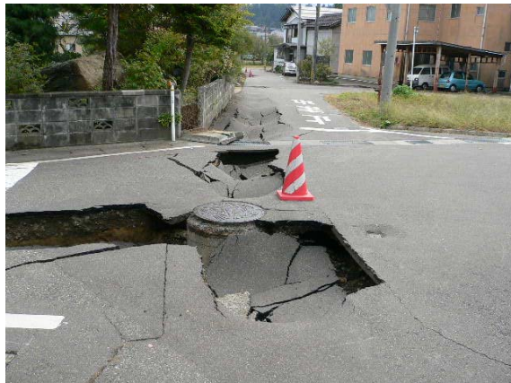
写真 6.3 管路埋設路線上の地盤沈下 (小千谷市)
