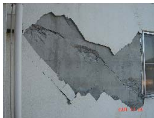
写真 10.3.15 昭和 44 年竣工棟の梁端の曲げひび割れ
