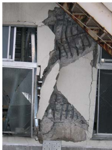
写真 10.3.13 昭和 43 年竣工棟の短柱のせん断破壊
