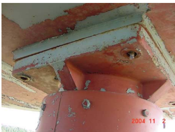
写真 9.1.38 ピボット支承セットボルトの破損（越の大橋）
