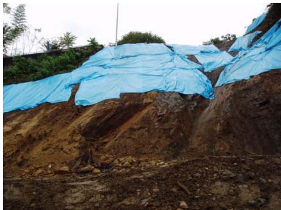
写真 9.2.57 岩盤崩壊の発生状況
