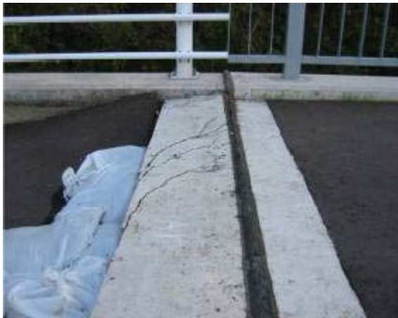
写真 9.1.30 橋台パラペットのひびわれ (観音橋側道橋)
