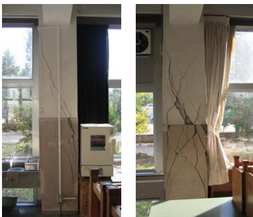
写真 10.3.11 特別教室の 1 階教室側柱のせん断破壊
