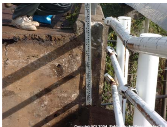
写真 9.2.9 約 75cm の段差が発生
