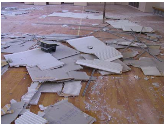
写真 10.3.28 落下した天井とスピーカー
