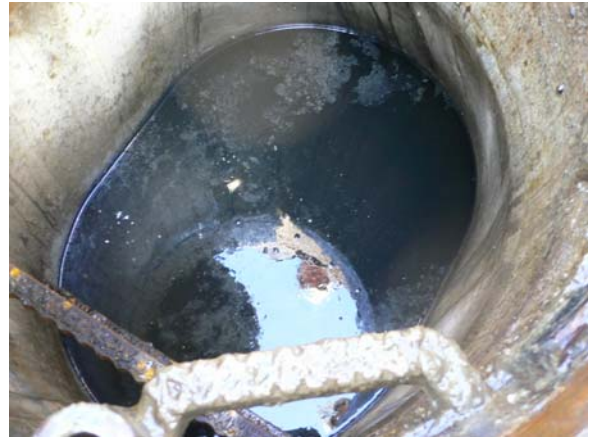
写真 6.8 マンホール内の滞水状況 (堀之内町)
