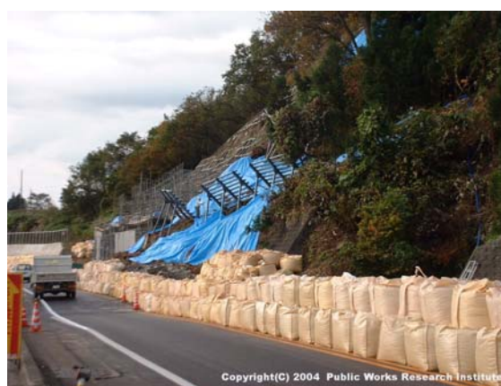
写真 9.2.12 被災したブロック積み擁壁 (11 月 1 日撮影)
