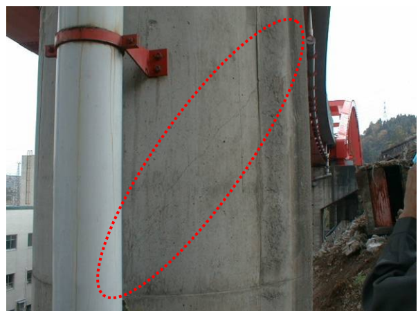
写真 9.1.23 P3 橋脚短柱側面の斜めひびわれ
