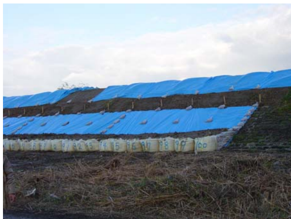
(c) 大型土のうによる緊急復旧状況 写真 7.1 信濃川右岸 2.0km 付近 (中之島町中条)
