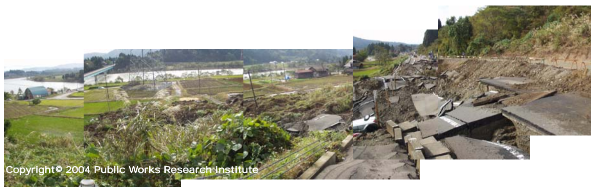
写真 G9. 2. 3 国道 117 号小千谷市塩殿における盛土部の崩壊
