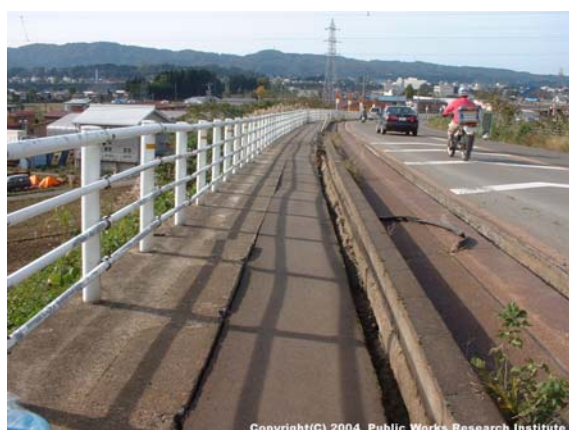
写真 9.2.10 擁壁の移動により発生した沈下とクラック
