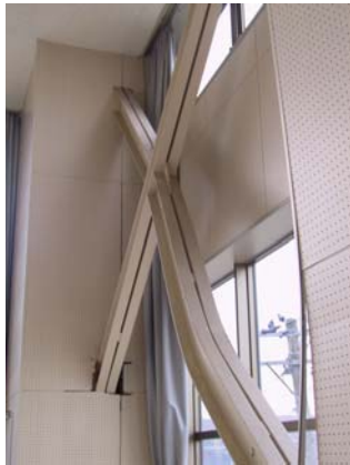
写真 10.3.35 ブレース材の座屈(47)
