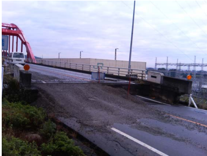
写真 G 9.1.1 国道 117 号 山辺橋 橋台背面の沈下によりできた段差状況
