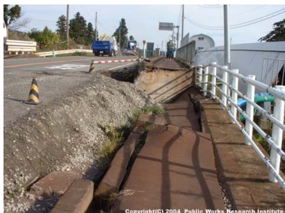
写真 9.2.8 取付盛土の沈下
