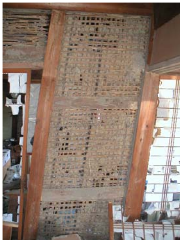
写真 10.3.3 塗り土が崩落した土壁
