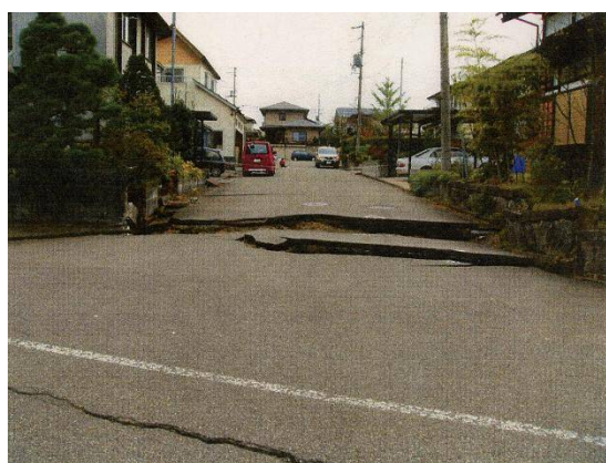
写真5.32 高町団地1丁目西側の亀裂発生状況
