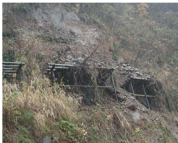
写真 5.40 雪崩予防柵の被災事例(2) (斜面崩壊による土石の堆積)
