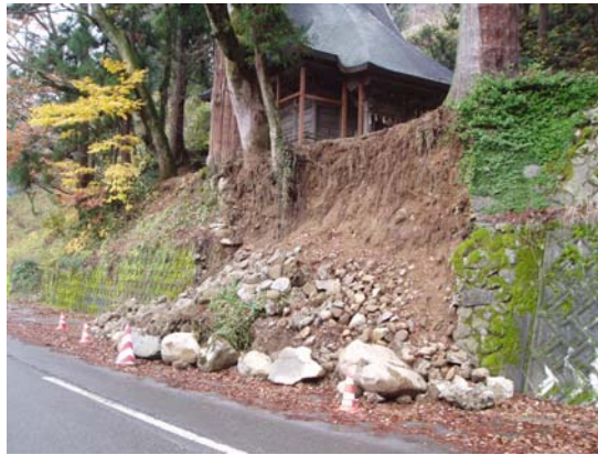
写真 9.2.34 石積擁壁の崩壊
