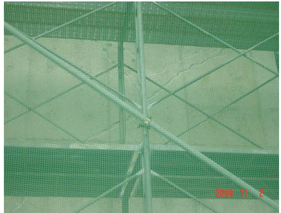
写真 9.1.49 固定橋脚に生じたせん断ひびわれ（芋川橋）
