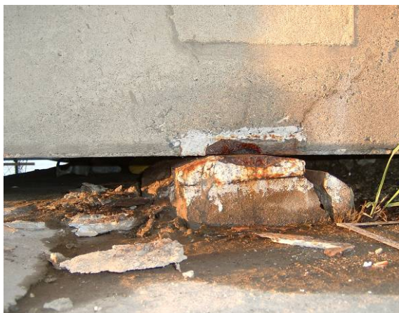
写真 9.1.42 桁コンクリートおよび支承沓座モルタルの剥離（栄橋）
