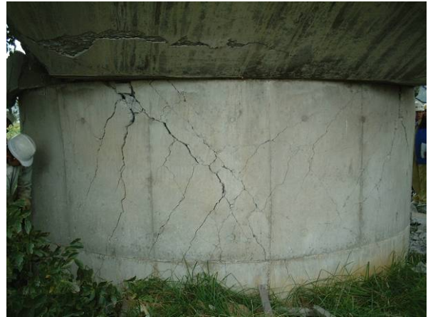
写真 9.1.10 P2 橋脚の損傷状況（拡大：上流側）
