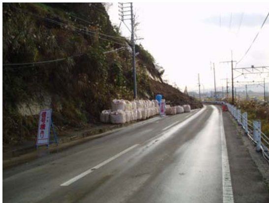
写真 9. 2. 25 のり面上部の表層が崩壊
