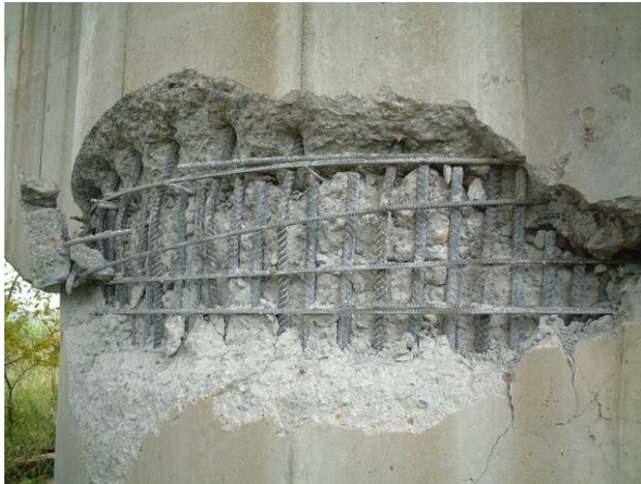
写真 9.1.9 P2 橋脚の損傷状況（拡大：P1側）
