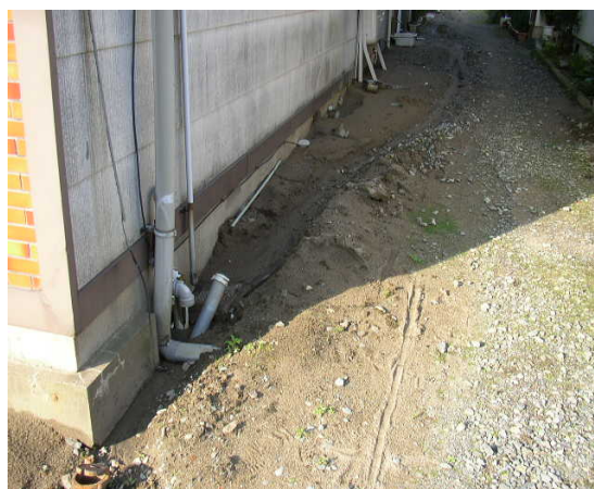
写真 10. 3. 40 液状化による被害（刈羽村）
