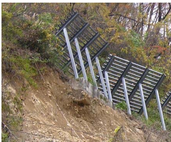
写真 5.39 雪崩予防柵の被災事例(1) (斜面崩壊による基礎の露出)
