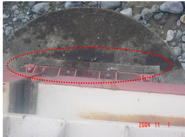
写真 9.1.55 沓座モルタルの損傷（姿大橋）
