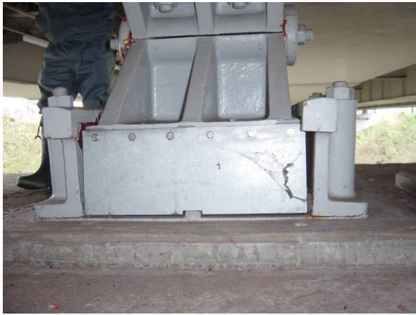
写真 9.1.28 サイドブロックの変形 (長岡大橋)
