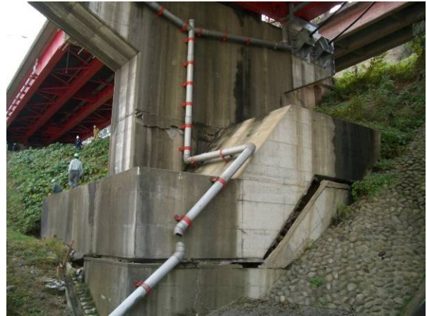
写真 9.1.19 P1 橋脚の損傷(P2 橋脚側)
