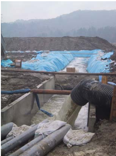
写真 6.9 仮設管渠からの流入 (堀之内浄化センター)
