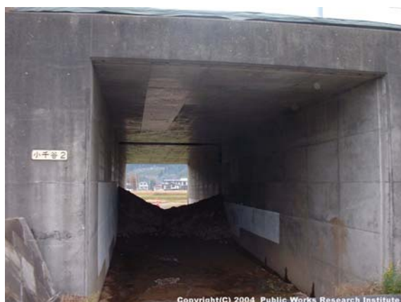
写真 9.2.20 継目部の開きにより盛土材が
