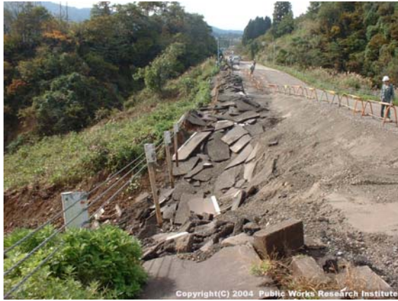
写真 9.2.5 崩壊部の路面状況
