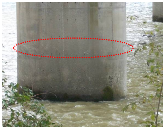
写真 9.1.51 橋脚に生じた水平ひびわれ（根小屋橋）
