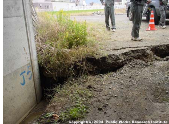
写真 9. 2. 24 ボックスカルバートの沈下
