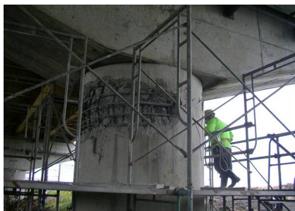
写真 9.1.3 P5橋脚の断面損傷状況
