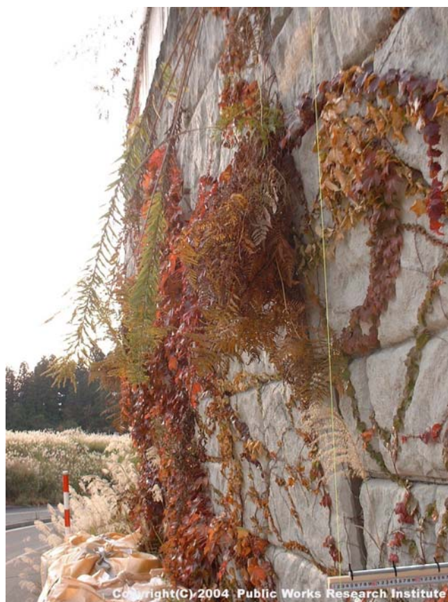
写真 G9. 2. 4 関越自動車道堀之内 IC 上り線ランプの補強土擁壁のはらみだし
