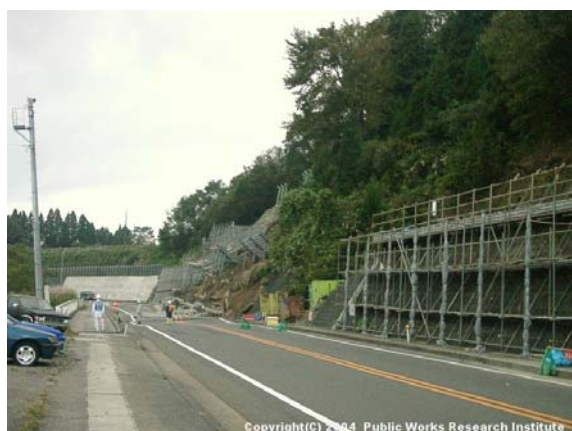
写真 9.2.11 被災したブロック積み擁壁 (10 月 25 日撮影)
