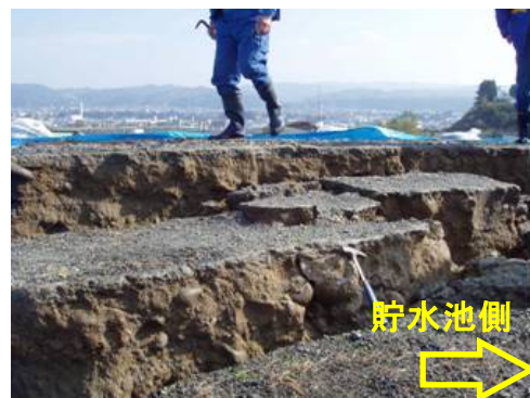
写真 8.2 天端亀裂による段差 (浅河原調整池)
