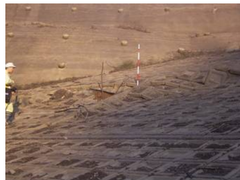
写真 8.16 上流のり尻から見た左岸上流のり面の変状（川西ダム）
