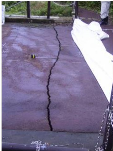
写真 8.11 天端の上下流方向に発生した亀裂 (長福寺ダム)
