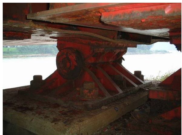
写真 9.1.14 箱桁下フランジの変形(P5 橋脚上)
