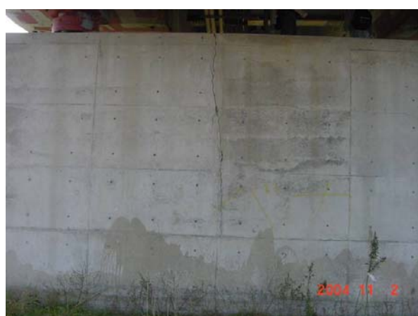
写真 9.1.37 P1 橋脚の垂直ひびわれ（越の大橋）
