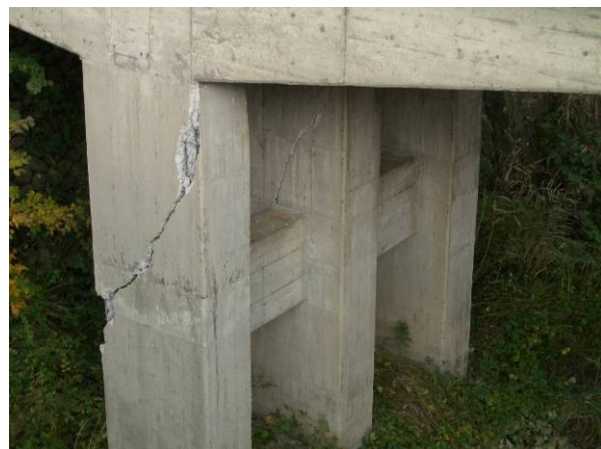
写真 9.1.57 ラーメン柱部に生じたせん断ひびわれ（浦柄橋旧橋）
