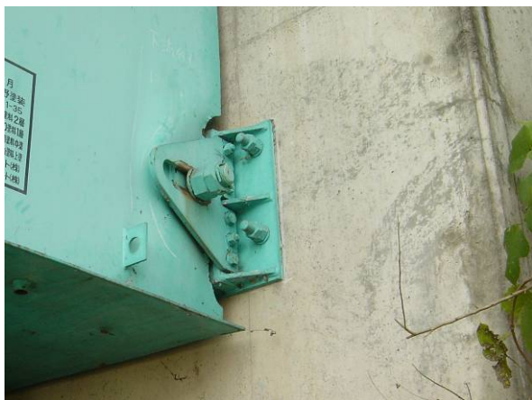
写真 9.1.58 橋台部落橋防止装置の変形状況（川井大橋）
