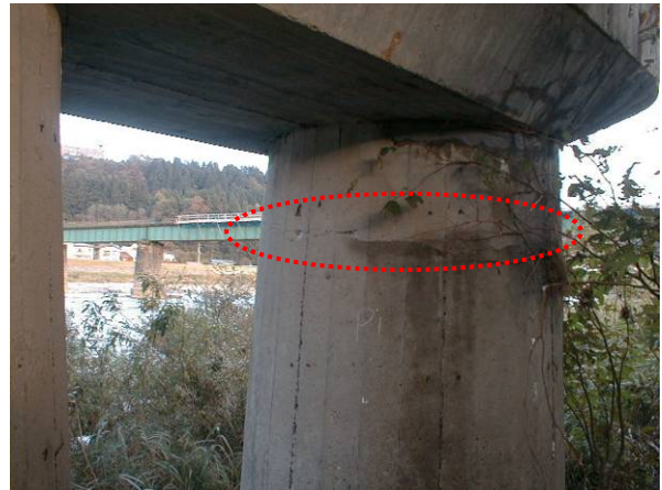
写真 9.1.53 左岸側 1 本目の橋脚の上流側柱頭部に生じた水平ひびわれ（川口橋）
