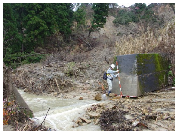
写真 5.28 左袖が破損した神沢川第一砂防えん堤
