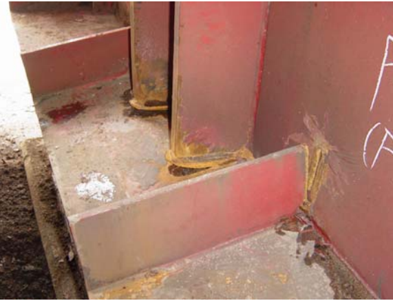
写真 9.1.15 支承上補剛材端部の亀裂・破断 (P4 橋脚上)
