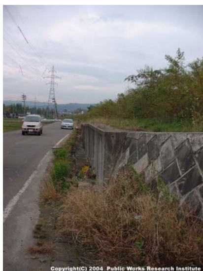
写真 9.2.15 L 型擁壁の傾斜
