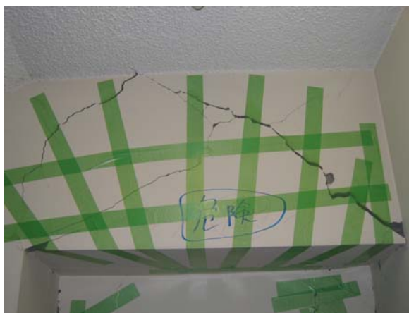
写真 10.3.14 昭和 44 年竣工棟の短スパン梁のせん断破壊
