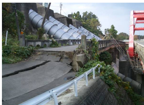
写真 9.1.27 旧山辺橋（左）の橋台背面盛土
