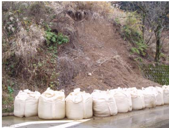
写真 9.2.35 切土のり面の崩壊状況
