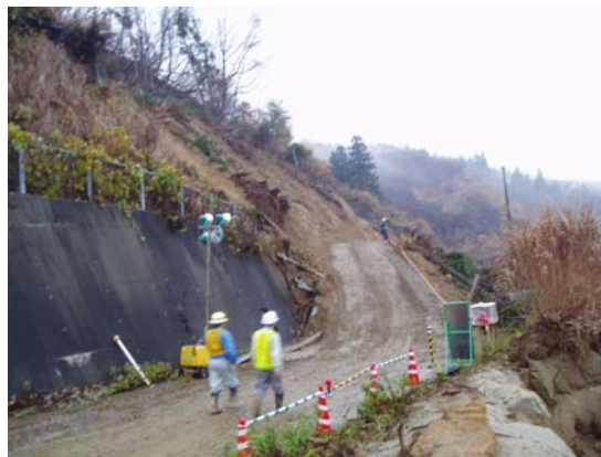
写真 9.2.53 崩積土の道路横断状況
