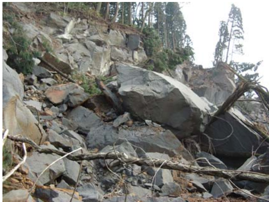
写真 9.2.51 崩壊頭部の状況
