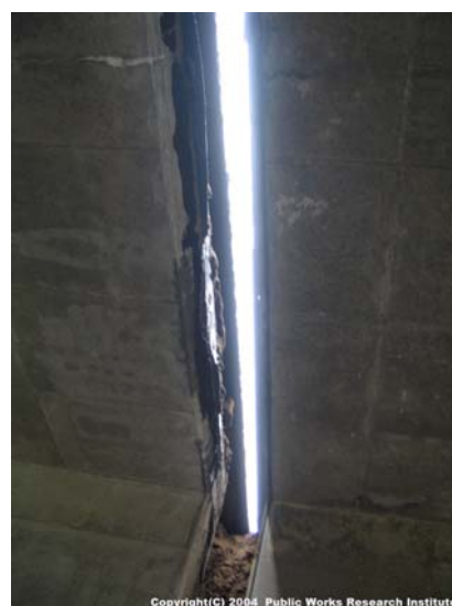
写真 9.2.22 継目部の開き
