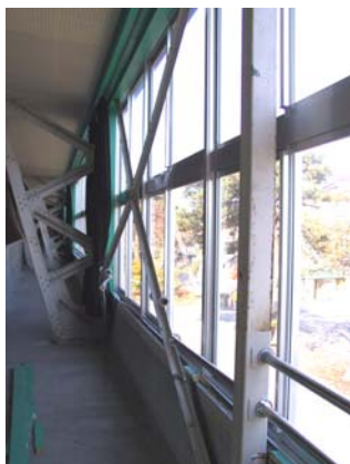
写真 10.3.22 ブレース材座屈(15) 写真 10.3.23 つづり部での亀裂(18)
