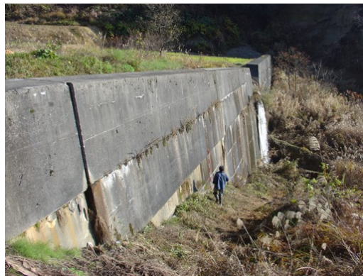
写真 5.13 袖部の上部のコンクリートブロックほど水平移動量が大きいことがわかる。最上部ブロックはその下に比べて 20cm ほど下流に移動している。
