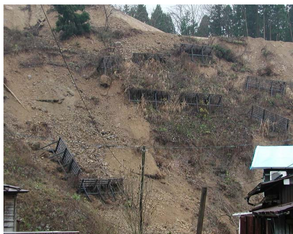
写真 5.39 雪崩予防柵の被災事例(1) (斜面崩壊による基礎の露出)
