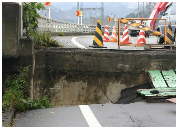
写真 9.1.26 A2 橋台背面盛土の沈下
