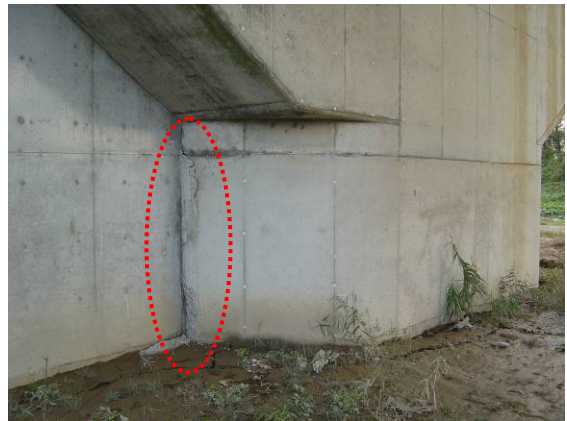
写真 9.1.47 RC壁連結部でのかぶりコンクリートの剥離（大手大橋）
