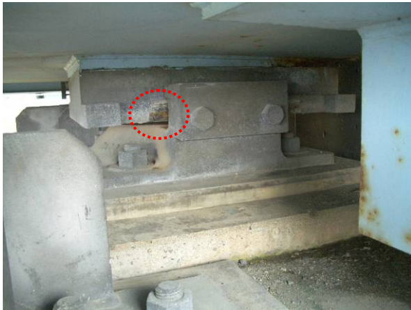
写真 9.1.52 BP 支承に生じた擦過痕（越路橋）
