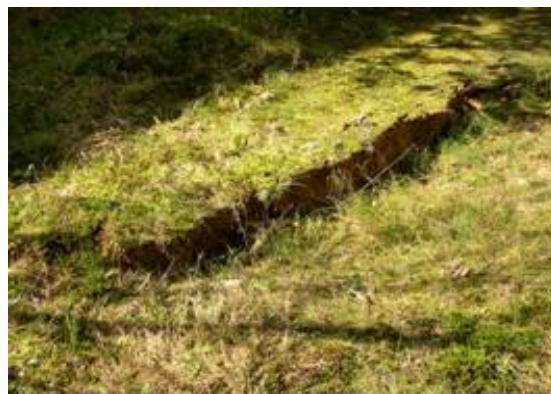
写真 10. 3. 41 液状化による地盤の隆起と宅地内の地割れ（長岡市）
