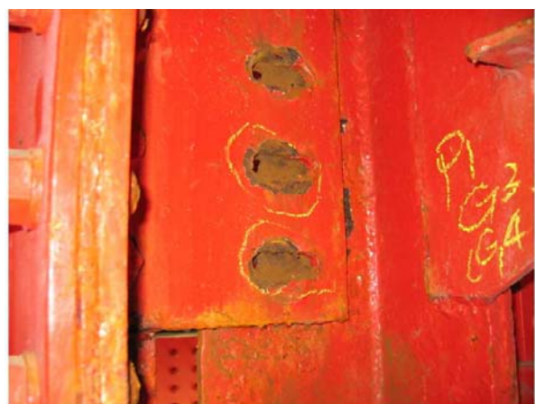
写真 9.1.36 P1-P2 ゲルバー部におけるボルトの破損（和南津橋）
