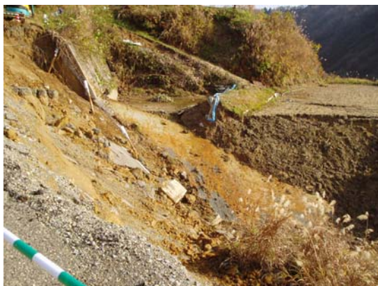
写真 9. 2. 54 層理面上の表土・耕作土の崩壊
