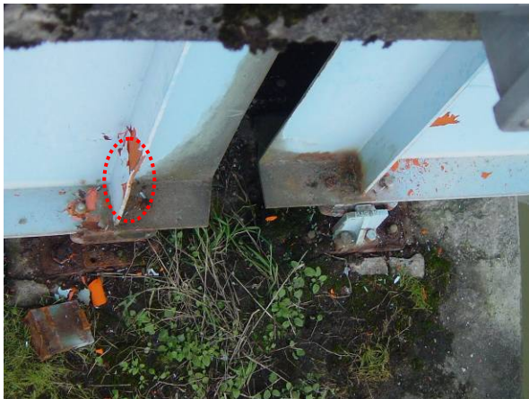
写真 9.1.54 支点上垂直補剛材の座屈（西倉橋）
