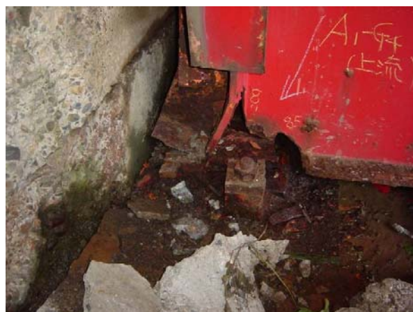
写真 9.1.35 A1 橋台上主桁の損傷（和南津橋）
