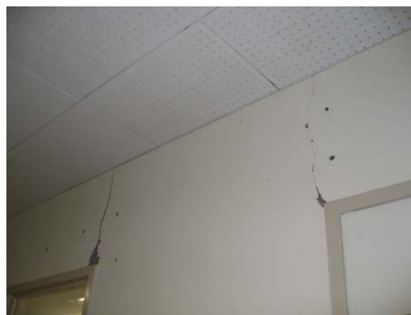
写真 10.3.15 昭和 44 年竣工棟の梁端の曲げひび割れ
