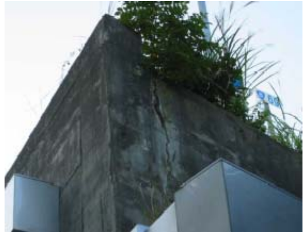
写真 9.1.29 A2 橋台ウイング部のひびわれ (宮本橋)
