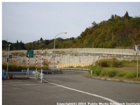
写真 9.2.18 補強土擁壁の全景
