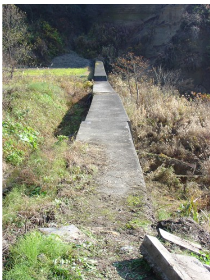
写真 5.14 右岸側袖部が打継目で分離し、移動している。また背後の堆砂との間に開口が見られる。
