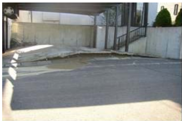
写真 10. 3. 41 液状化による地盤の隆起と宅地内の地割れ（長岡市）
