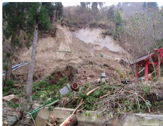
写真 9. 2. 56 くさび崩壊の発生状況
