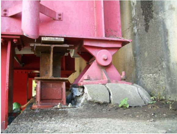
写真 9.1.46 左岸側橋台部支承部の損傷状況（宮中橋）
