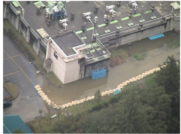
写真 6.2 流入下水の漏水
