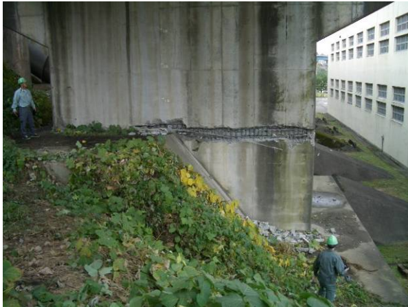
写真 9.1.18 P1 橋脚の損傷(A1 橋台側、かぶりコンクリートの剥落、軸方向鉄筋のはらみだし、帯鉄筋の重ね継手のはずれ)
