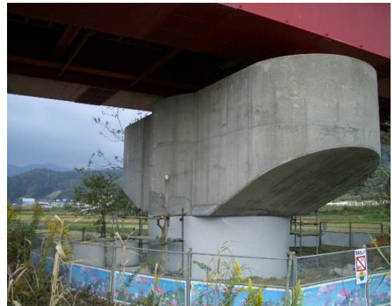
写真 9.1.16 P2 橋脚の炭素繊維シート 巻立てによる応急復旧状況
