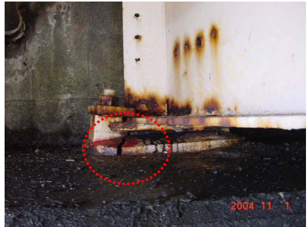
写真 9.1.31 A2 橋台部支承下沓のわれ (新佐梨橋)
