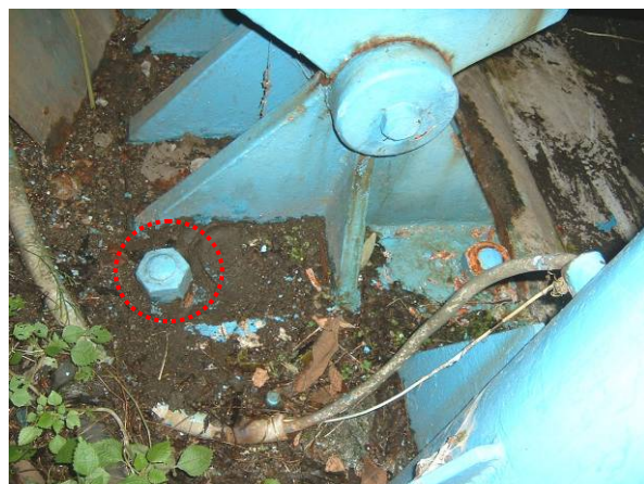
写真 9.1.41 ランガーアーチ固定支承部のアンカーボルトの引き抜け（魚沼橋）
