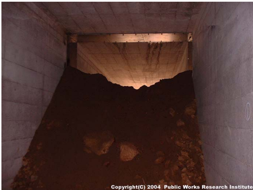
写真 G9. 2. 2 関越自動車道のボックスカルバート内に流入した盛土材 礫混じりの盛土材が流入し、継目部には鉄板による補修が施されている。
