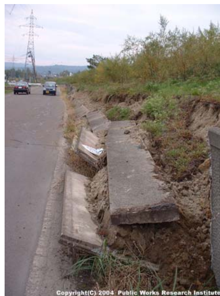
写真 9.2.16 倒壊した L 型擁壁
