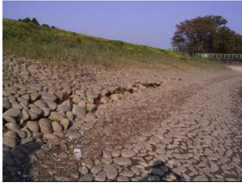
写真 8.9 貯水池側のり面のすべり変状 (山本調整池)
