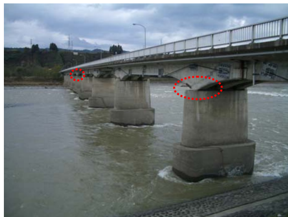
写真 9.1.43 橋軸直角方向の変位制限構造のはずれ（十日町橋）
