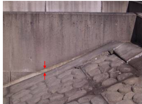
写真 8.12 洪水吐と張りブロック間の沈下 (長福寺ダム)
