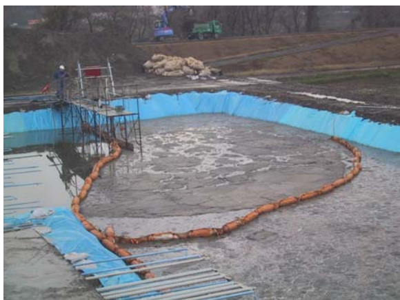
写真 6.11 汚泥引き抜き作業 (堀之内浄化センター)
