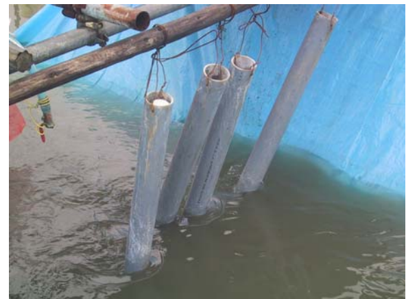
写真 6.12 固形塩素の供給 (堀之内浄化センター)
