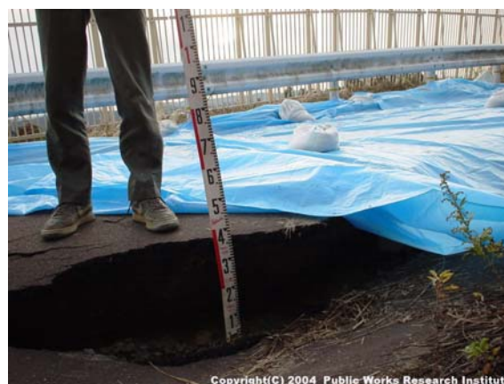
写真 9.2.19 天端部での沈下
