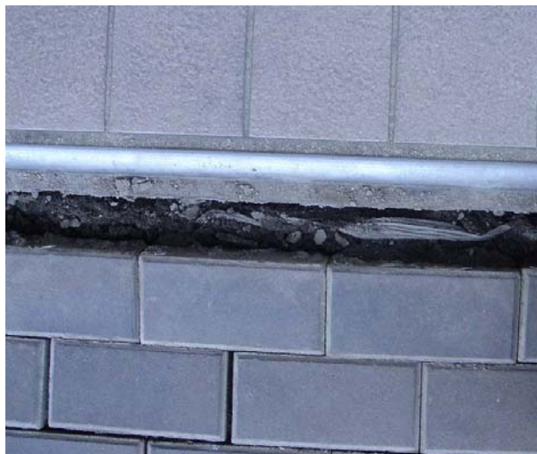
写真 10.3.43 正面入口付近の免震・非免震部分の様子
