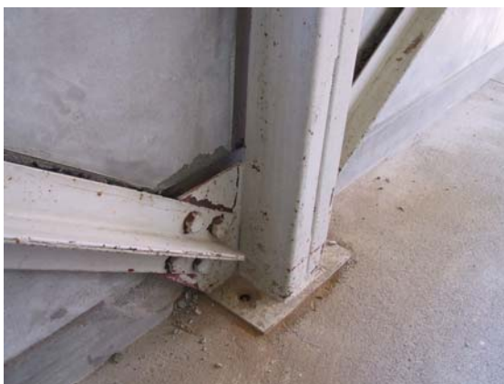
写真 10. 3. 21 間柱脚部アンカーボルト破断(16)
