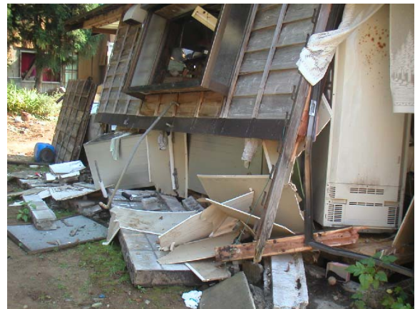
写真 10.3.8 ブロック基礎の立ち上がり部分の崩壊
