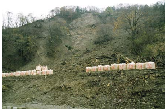
写真 9.2.60 浅い岩盤崩壊の発生状況
