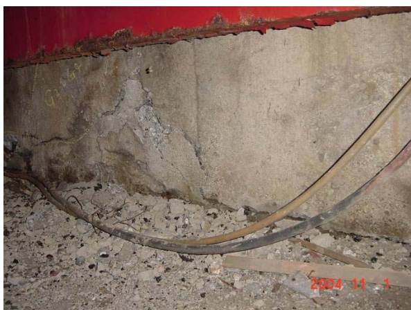
写真 9.1.34 橋台パラペットのひびわれ（和南津橋）
