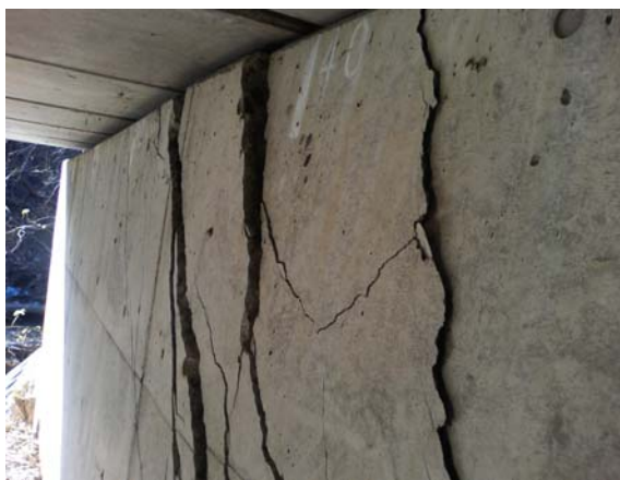
写真 9.1.44 橋台に生じた斜めひびわれ（錦鯉橋）
