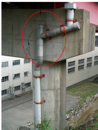
写真 9.1.22 P3 橋脚梁部のひびわれ
