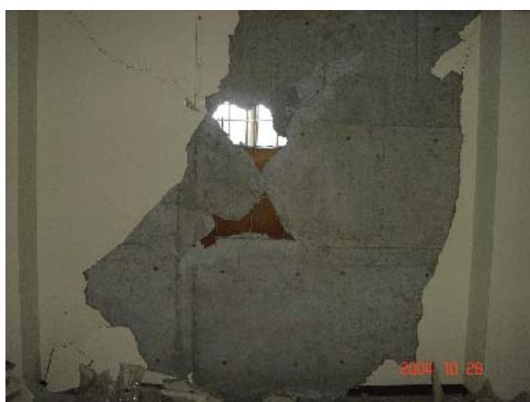
写真 10.3.16 昭和 44 年竣工棟の壁部材のせん断破壊
