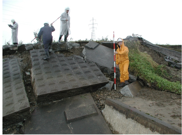
写真 7.8 妙見堰付近の低水護岸の損壊
