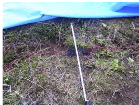
写真 8.14 下流のり面の亀裂 （坪山ダム）
