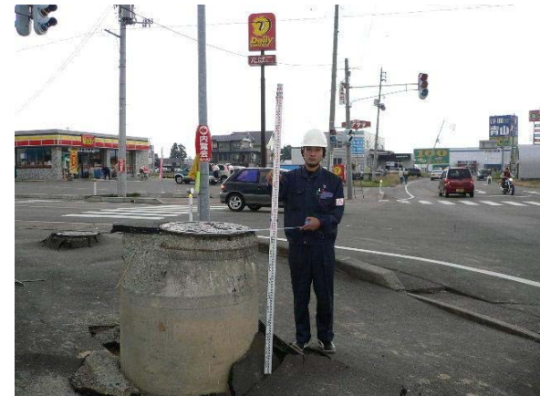
写真 6.4 マンホールの浮上がり (小千谷市)
