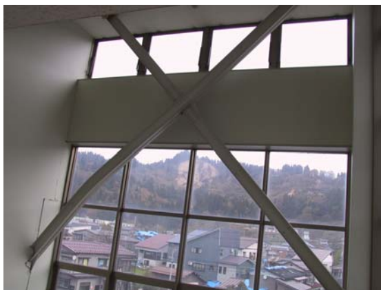
写真 10. 3. 33 ブレース材の座屈(40)
