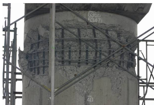
写真 9.1.4 P5橋脚の断面損傷状況（拡大）
