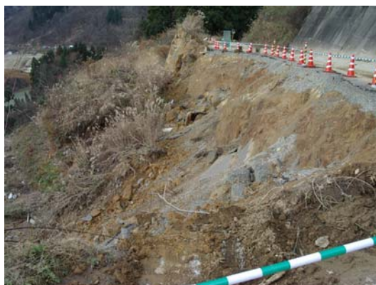
写真 9.2.59 表層崩壊による道路被害状況
