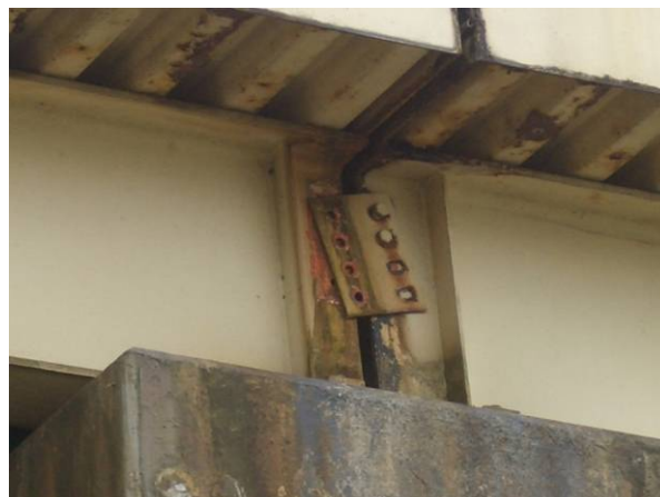
写真 9.1.45 桁間連結プレート boltsのはずれ（旭橋）
