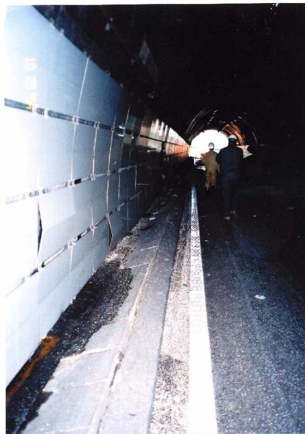
写真 G9. 3. 2 国道 1 7 号和南津トンネルの側溝の変状状況
