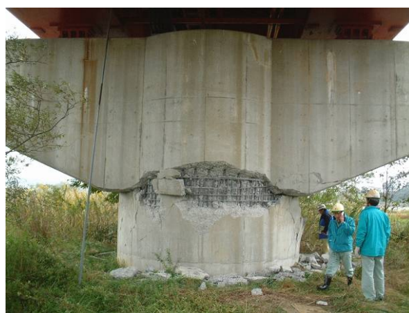
写真 9.1.8 P2 橋脚の損傷状況
