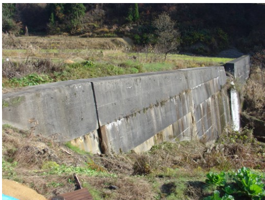
写真 5.12 水沢新田地区の砂防堰堤の右岸側袖部。打継目でコンクリートが分離してブロックが移動したことがわかる。
