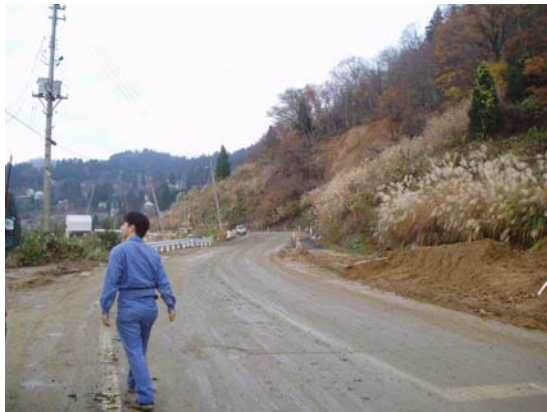
写真 9. 2. 30 切土のり面の崩壊 (山古志村役場の北東)
