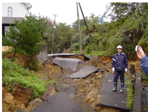
写真 5.34 鶴ヶ丘団地北部最下段宅地斜面における崩壊状況
