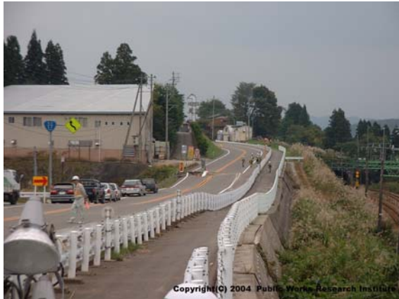
写真 9.2.3 崩壊部周辺の沈下状況
