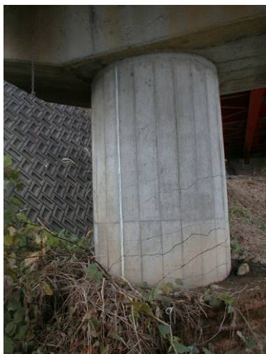
写真 9.1.24 P4 橋脚（短柱側）の水平・斜めひびわれ
