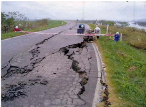
(a) 堤防天端の縦断亀裂と段差 (北陸地方整備局撮影)
