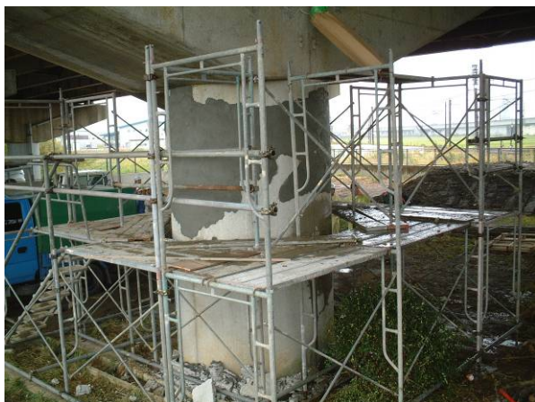
写真 9.1.5 モルタルによる断面修復後の状況 (P5 橋脚。この後に炭素繊維シートを巻立てる。)
