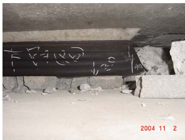
写真 9.1.39 ゴム支承の変形（十日町高架橋）
