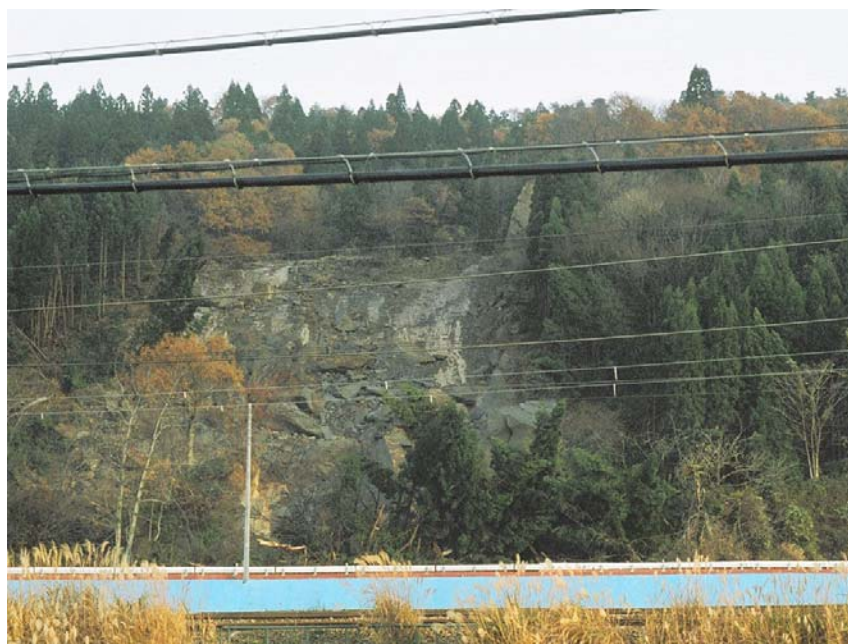
写真 G9. 2. 7 国道 291 号小千谷市横渡における岩盤崩壊
