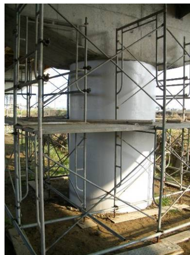
写真 9.1.6 炭素繊維シート巻立てによる応急復旧状況 (P6 橋脚)
