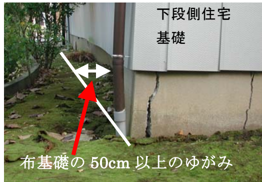
写真 10.3.39 斜面下部の住宅（B 邸）の被害状況
