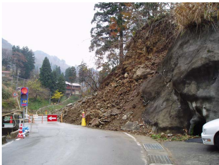
写真 G9.2.5 県道 23 号長岡市濁沢町における切土のり面崩壊
