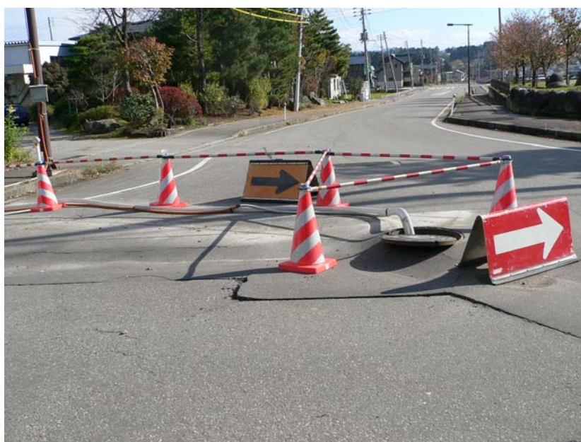
写真 G 6.2 小千谷市若葉地区の管渠の応急復旧状況
