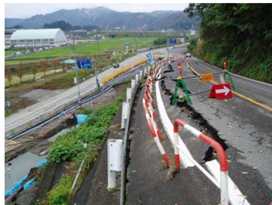
写真 9.2.58 道路の被害状況
