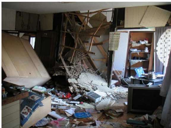
写真 10.3.7 内壁の脱落
