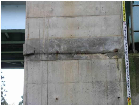
写真 9.1.48 橋脚かけ違い部の水平ひびわれ（塩殿橋）
