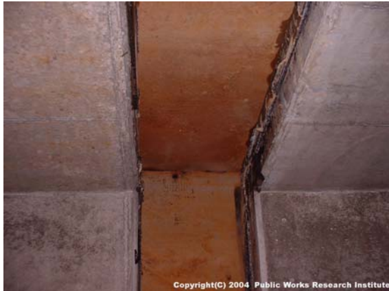
写真 9. 2. 23 継目部の応急補修状況
