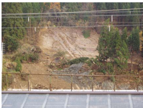
写真 9.2.42 北側の崩壊箇所のすべり面
