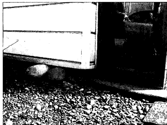
写真 10.50 玄関付近 (基礎が確認できない)
