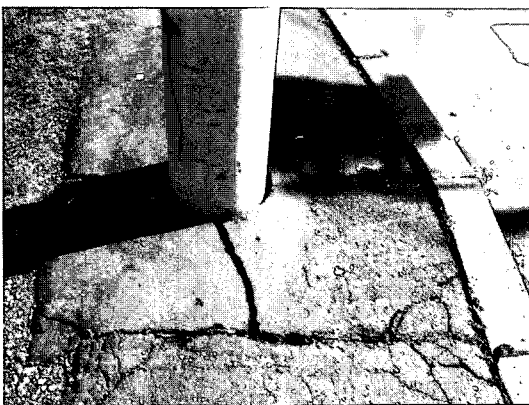
写真 10.67 駅近くの道路
