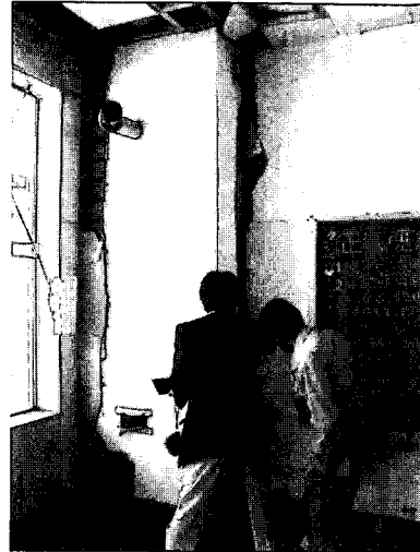
写真 10.44 鉄骨造部分（3階）
