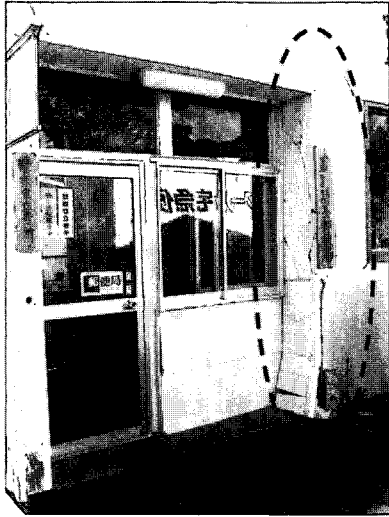
写真 10.63 簡易郵便局 (外壁にひび)
