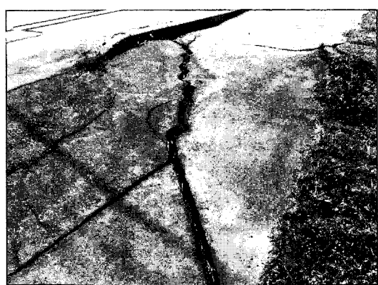
写真 10.68 駅近くの道路
