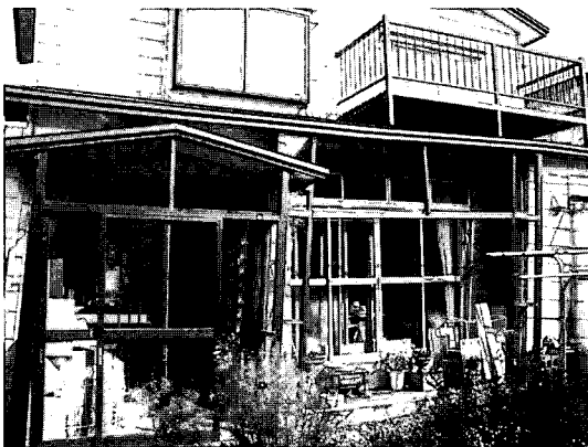
写真 10.49 外観 (右側に大きく傾いている)
